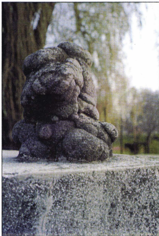
Concretiune grezoasă tip “Gresarea” pe fântâna din parcul localității Bârzesti (VL)
