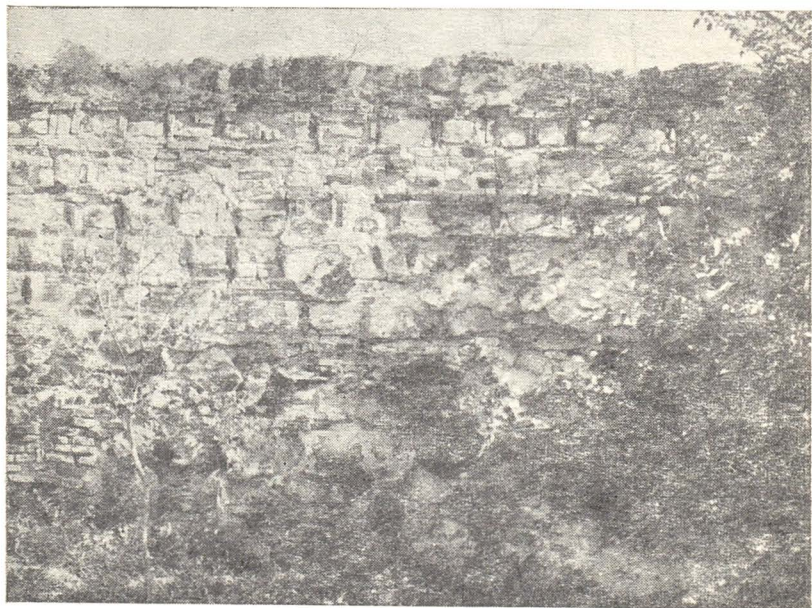
Zidurile de 4 m înălțime din cărămidă și piatră, ce formau cetățuia Mănăstirii.
