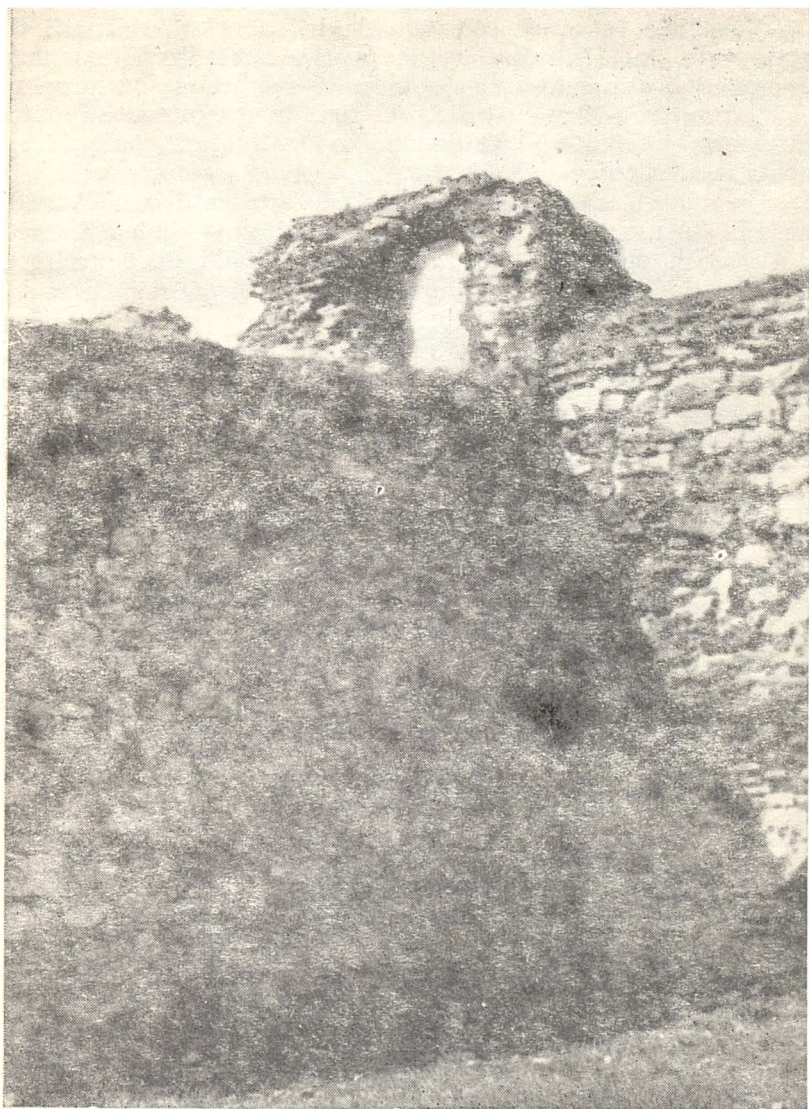
Masivele ziduri din sec. al XVI-lea ale unor construcții folosite ca chilii sau, după tradiție, ca locuință a comisului.
