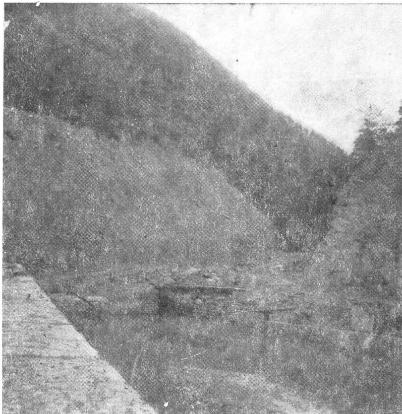
Vedere din zona barajului de la Paltinul — începutul lucrărilor.
