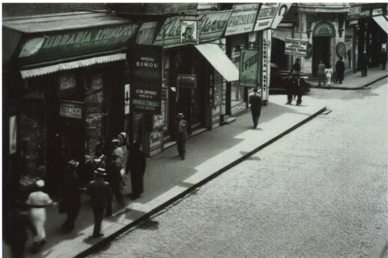
Foto 59. Str. Domnească colț cu str. Fraternității
