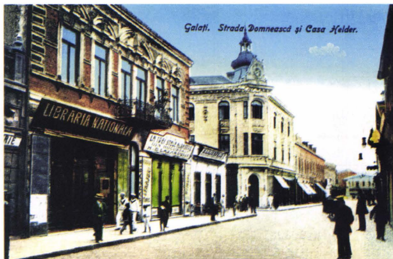
Foto 79. Casa „M. Helder” din intersecție
