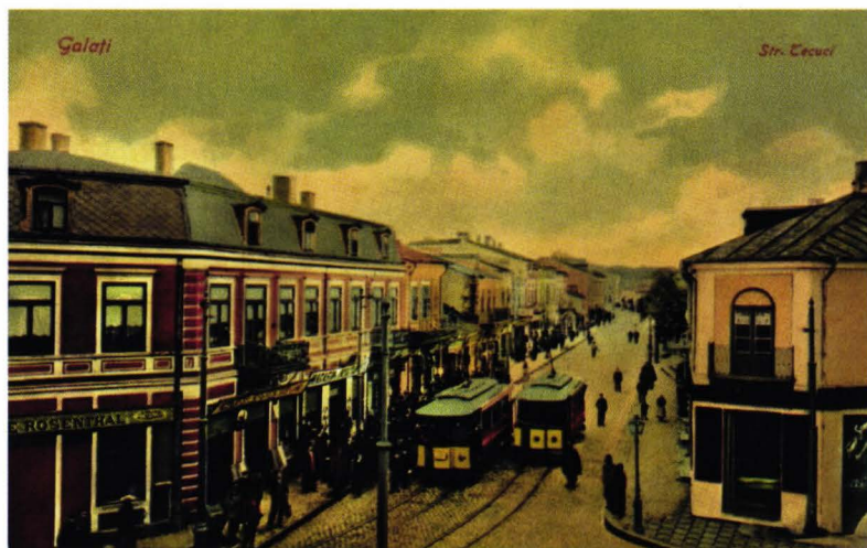
Foto 61. Intersecția str. Tecuci-str. Mavromol
