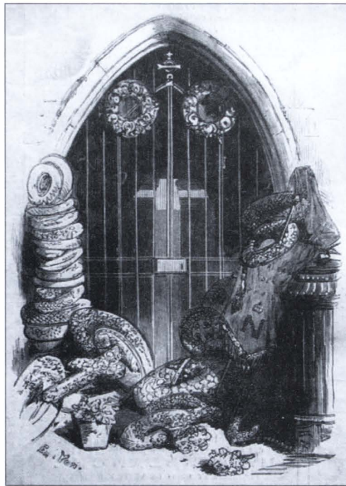
Cavoul unde au fost depuse rămășițele pământești ale lui Napoleon al III-lea, în „Le Monde Illustré”, No. 824/25 ianuarie 1873.
