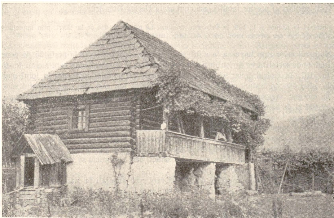
Fig. 2. — Casă cu 2 rînduri. Rîndul de jos construit din zid, iar etajul din bîrne.
