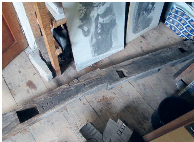
Fig. C 5. Bârna de la talpă – bârna-mamă, adusă în atelier.
