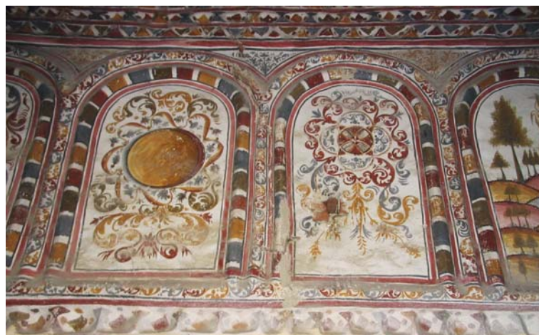
Fig. 20. Neghinești, fațada nordică - motive decorative.
