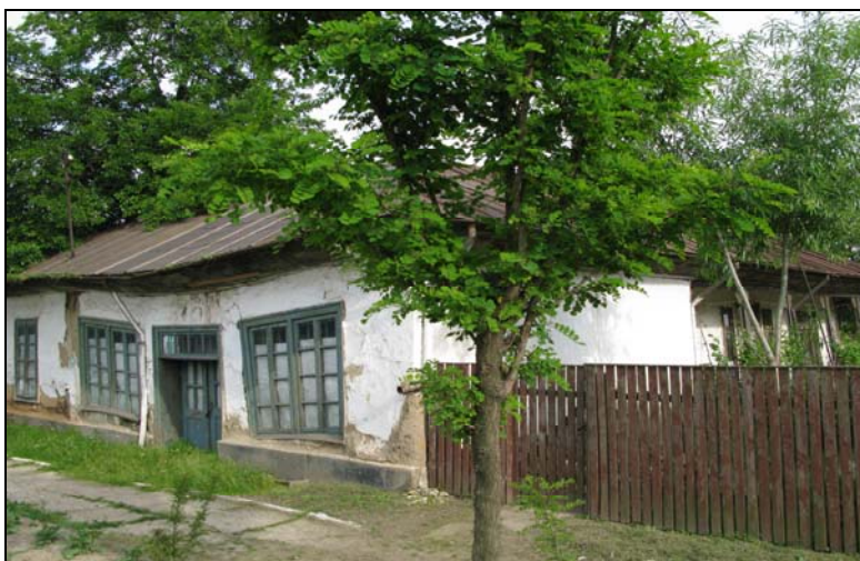
Fig. 19. Casa de pământ cu prăvălie Iulia Cristescu, Pietroșani.
