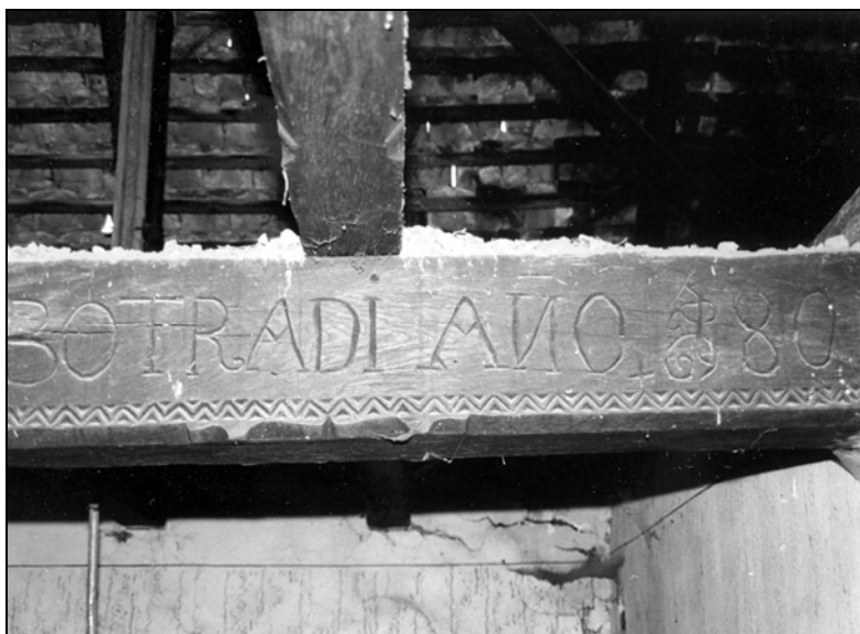
Fig. 17. Grinda longitudinală, cu datare 1802, a casei 238 (Domald).
