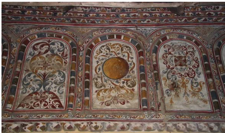
Fig. 19. Neghinești, fațada nordică - motive decorative.
