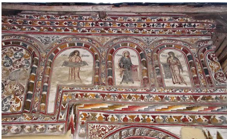
Fig. 21. Neghinești, fațada nordică - Sibilele.
