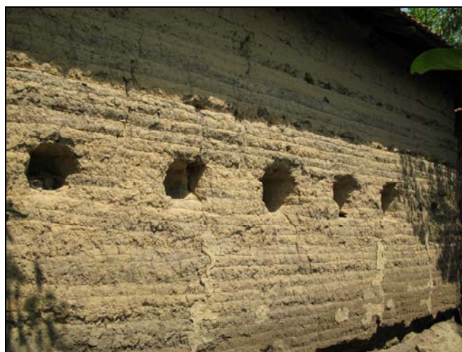
Fig. 15. Casă de pământ, Răducu Filip, Seaca. Perete lateral.
