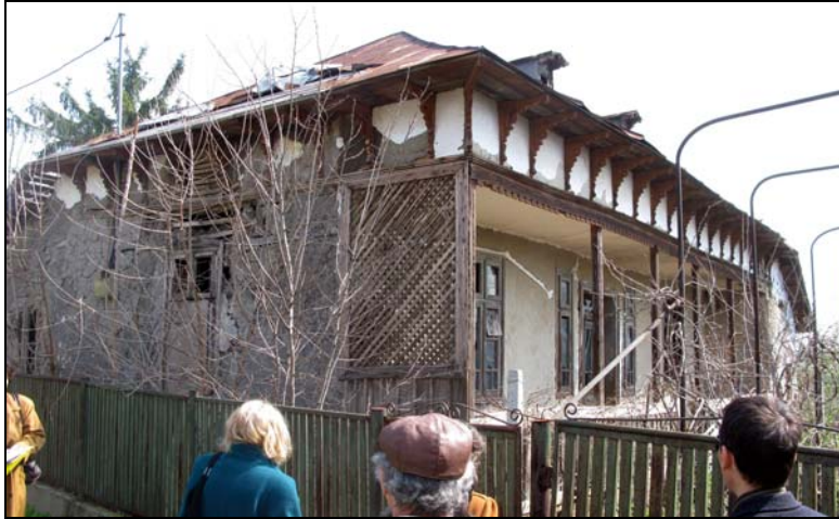
Fig. 17. Casa Trăncan Florea. Măgura (neclasată).
