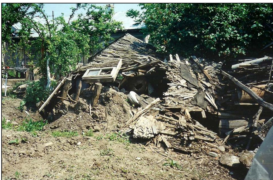
Fig. 2. Ruinele 'Casa Bordei' din Alexandria.
