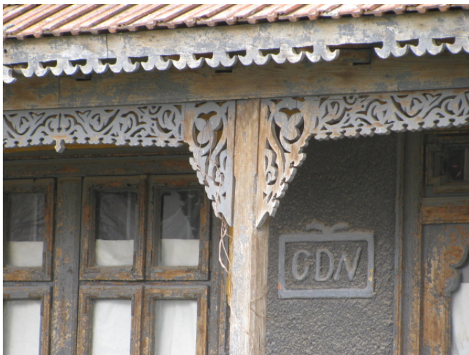
Fig. 9. Detaliu trafor prispă casă.
