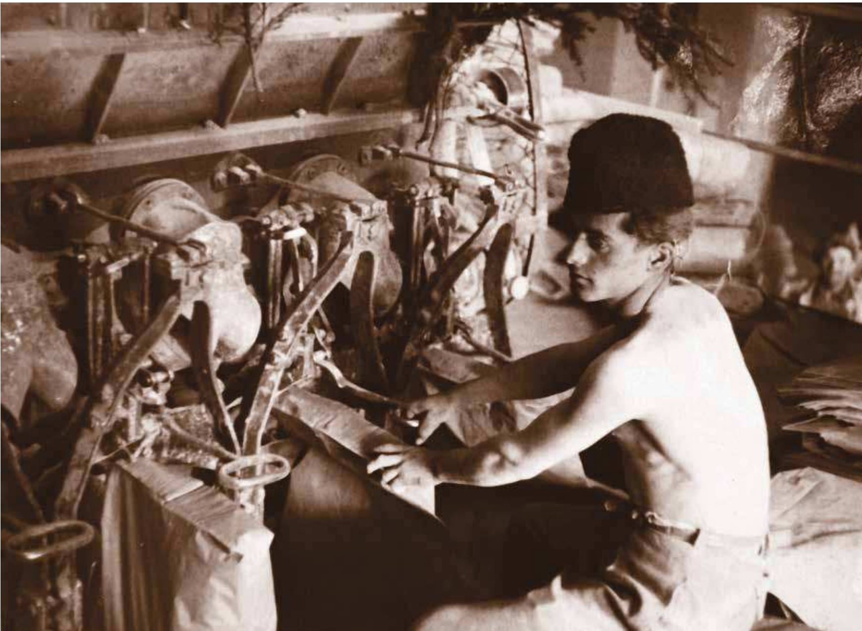
Prima mașină de înșăcuit tip Battes cu trei guri de încărcare
