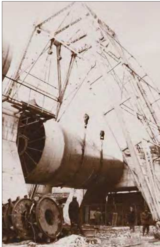
Montajul virolei de câmp la cuptorul nr. 7
