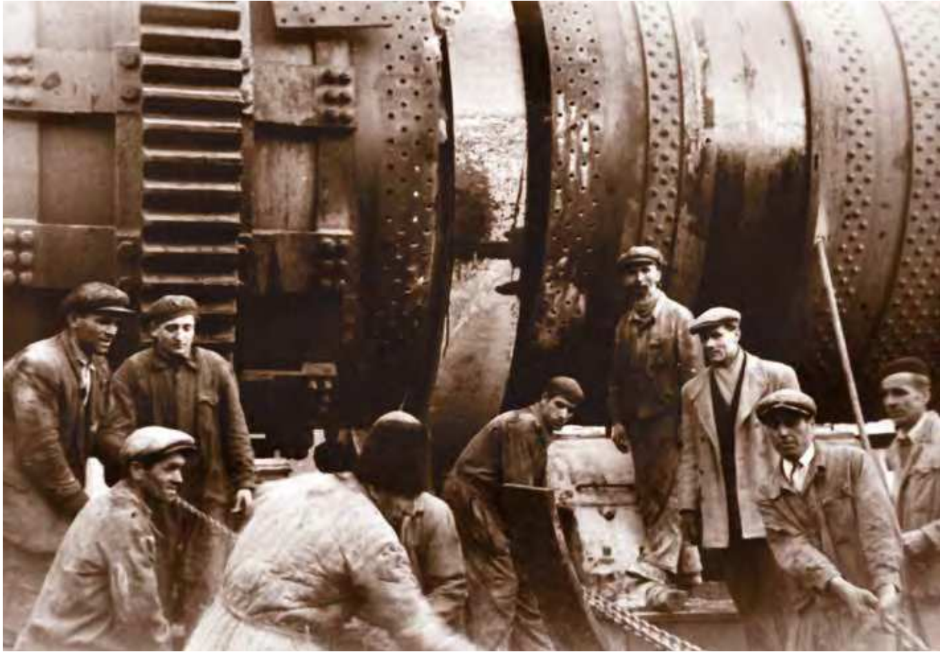
Reparație la cuptorul nr. 4
