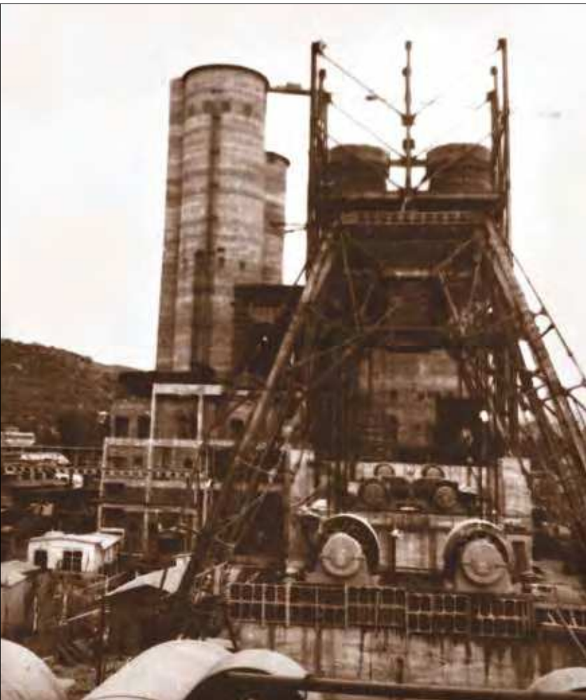
Grupurile de sprijin, montarea cuptorului nr. 7
