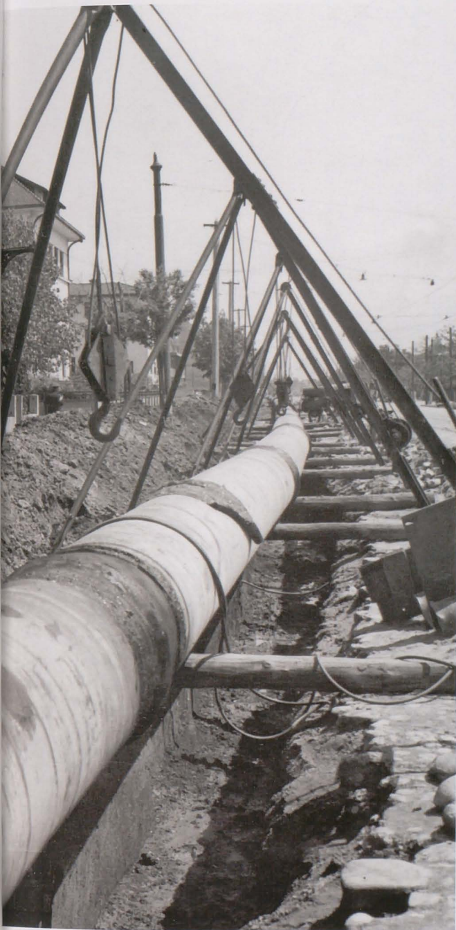
Montarea conductelor de gaze naturale cu ajutorul macaralelor, Șoseaua Panduri, București, 7 mai 1943
