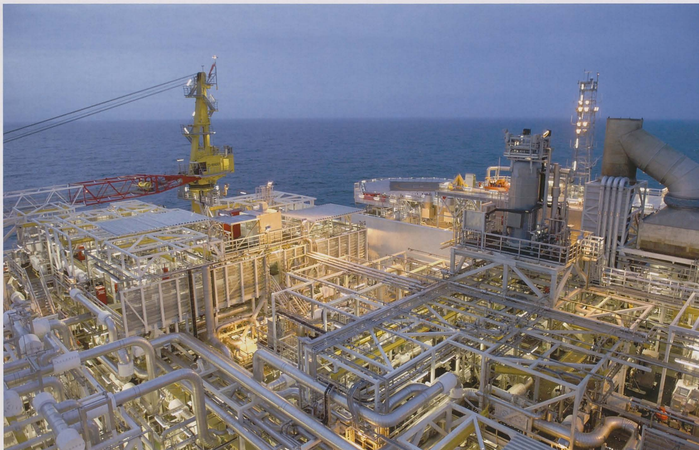
Platforma de exploatare a gazelor naturale operată de Grupul GDF SUEZ, în Marea Nordului
