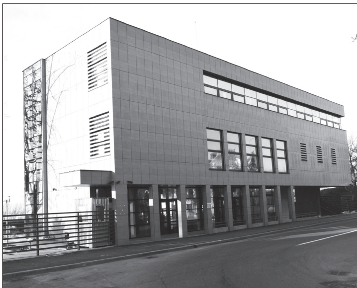
Pavilionul Multifuncțional (vedere din față)
