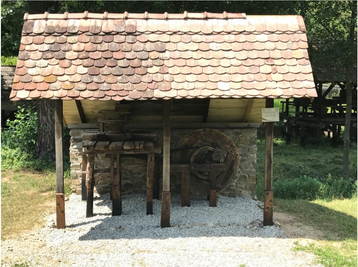
Ansamblu, după intervențiile de restaurare la monument
