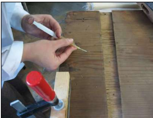
Aspecte din timpul operațiilor de degresare și înclieire a panoului
