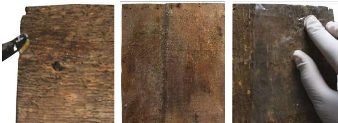
Aspecte din timpul și după operația de consolidare a capacului
