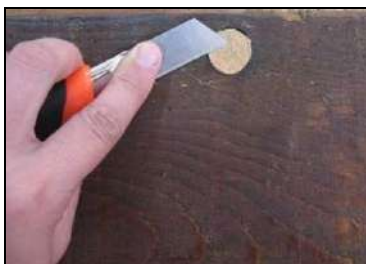
Aspecte din timpul obturării și integrării cromatice a nodului căzător
