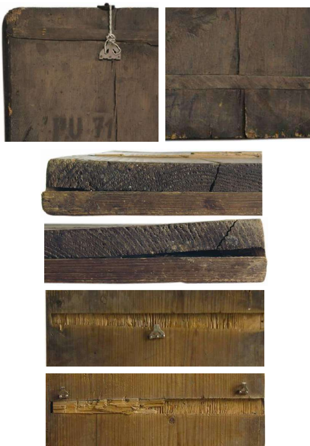
Degradări ale suportului din lemn: fisuri, crăpături, pierderi de material lemnos, curbarea panoului, detașarea baghetelor ramei, pierderea traverselor, slab atac de insecte xilofage
