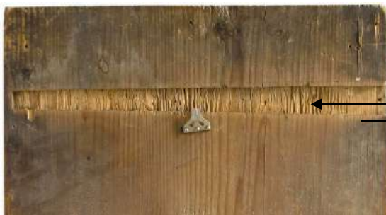
Prelevarea probelor din zona de sub traversa pierdută
