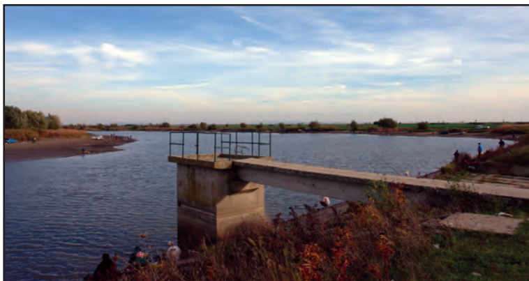
Fig. 22. Barajul Liebling. Fotografie de pe digul de barare al Tofaiei (2010)
