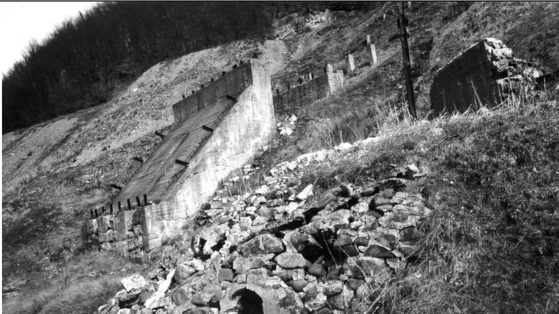
Abb. 18: Das Betonbett des Bremsberges zur Erzförderung aus dem „Motoceasca“- Erbstollen zu den Erzbunkern; auf erster Ebene erscheinen die Überbleibsel eines Trockenofens
