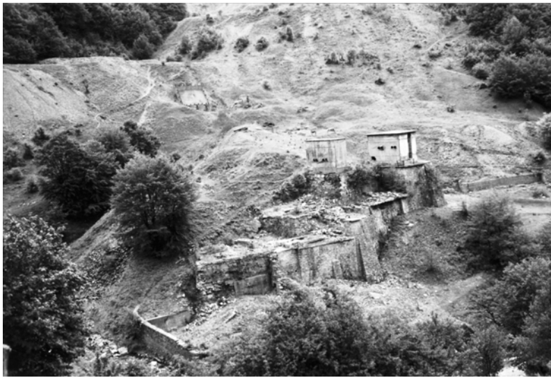
Abb. 19: Das ehemalige Betriebsgelände im Jahre 2007. Im Vordergrund die Spuren der beiden Quecksilberbrennöfen
