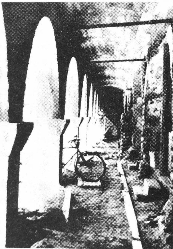
Fig.6. Porticul în timpul restaurării.
