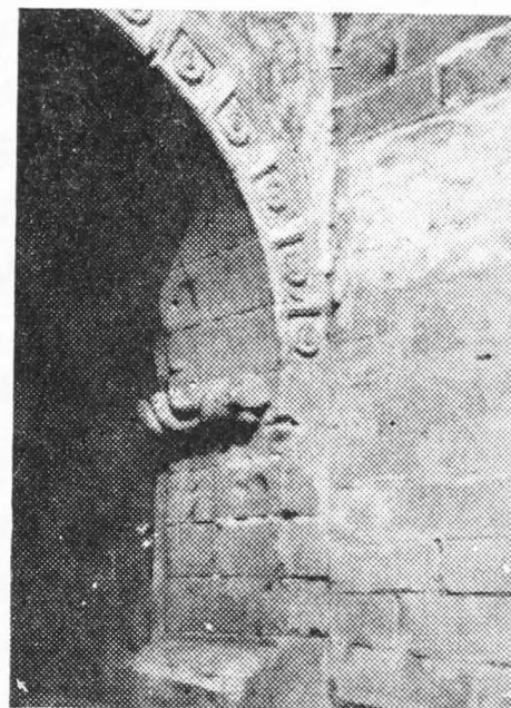
Fig.6 a. și 6 b. In interiorul incintei frînghia continuă pînă la zidăria arcului; în exterior, se întrerupe.
