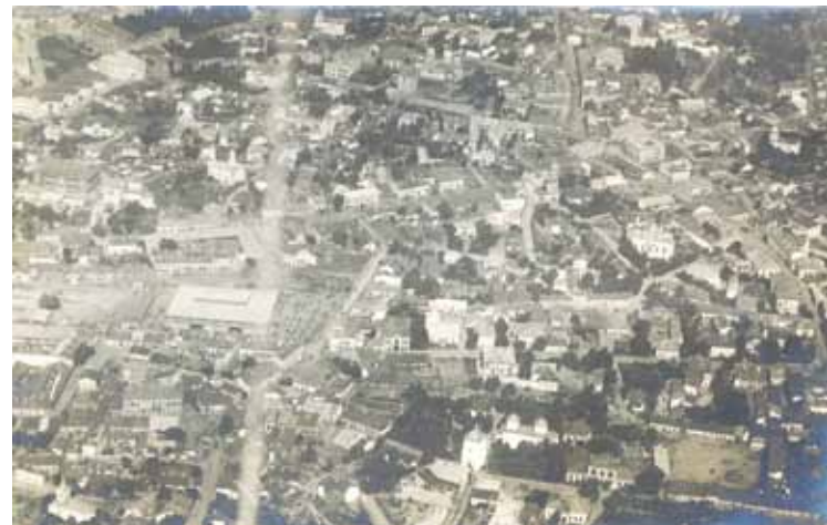
Vedere a zonei Halei Centrale
