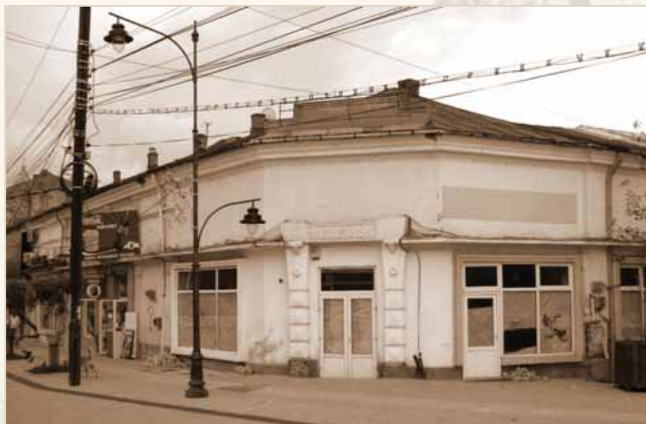
Clădirea din str. Ștefan cel Mare nr. 18-20, colț cu str. C. Langa
