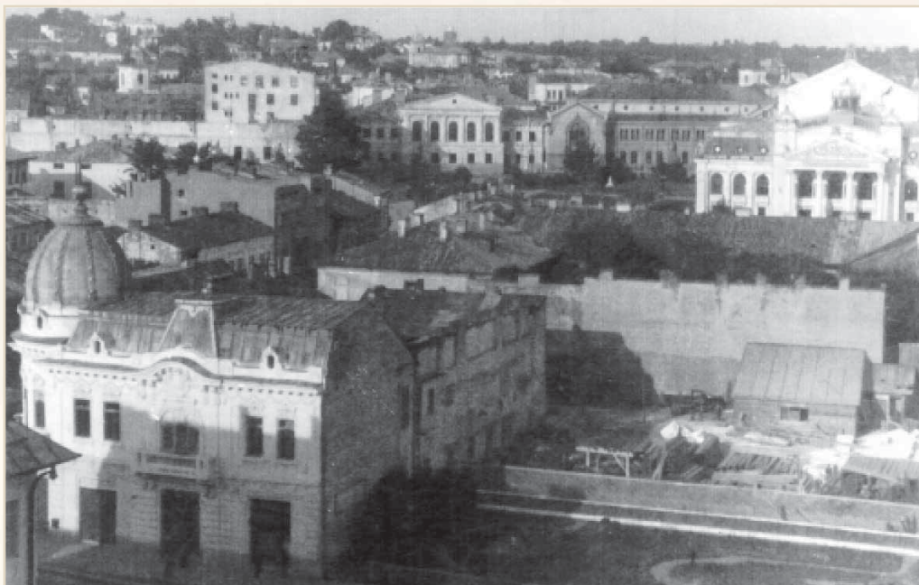
Casa Rocafux/Froim după 1940 (nr. 35)
