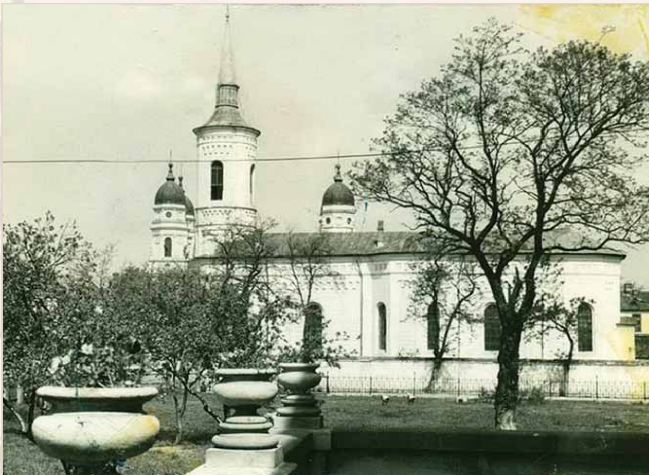
Biserica catolică, vedere dinspre Sud
