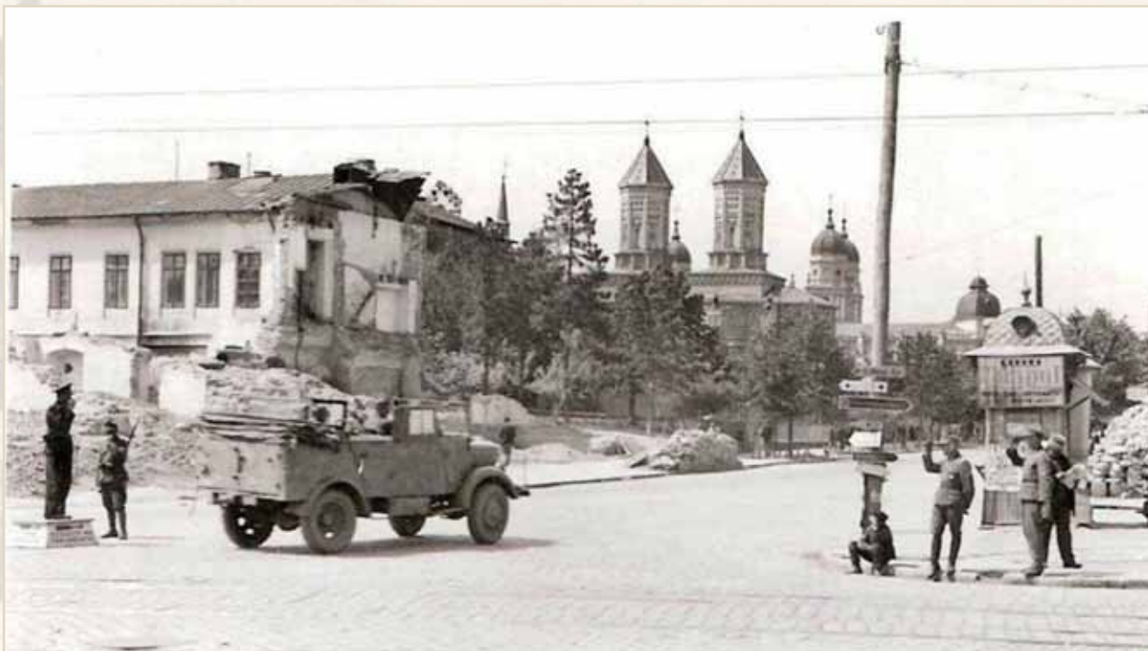
Ultima aripă a caselor Daniel, înainte de demolare (1940)
