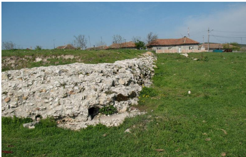
Zidul turnului de nord-vest Wall of the north-western tower
