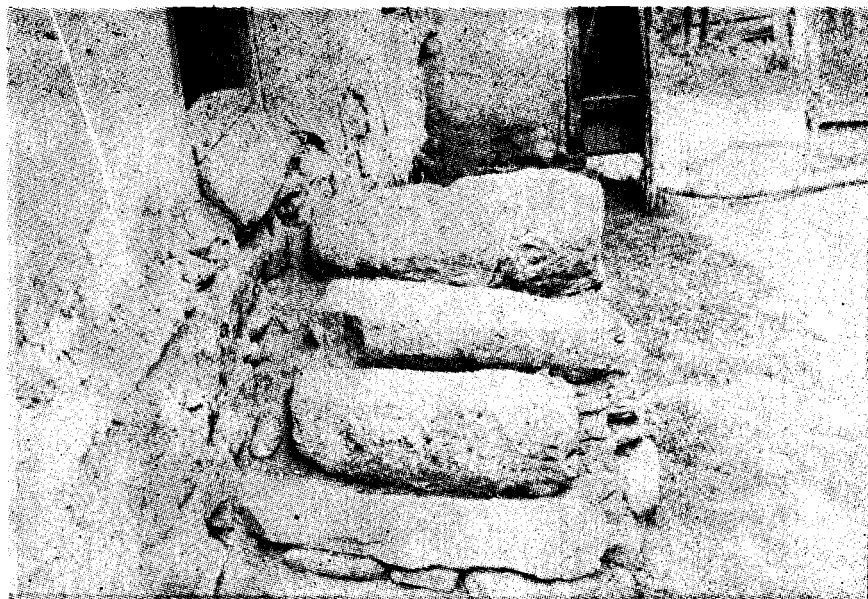
14. Blocuri paralelipipedice, din calcar cochilifer, folosite ca scări la locuința actuală a lui Dumitru Lălu (Tilișca, nr. 514)
