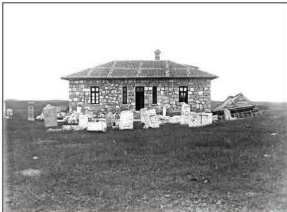
3. Maison du personnel (« bâtiment Pârvan »)
