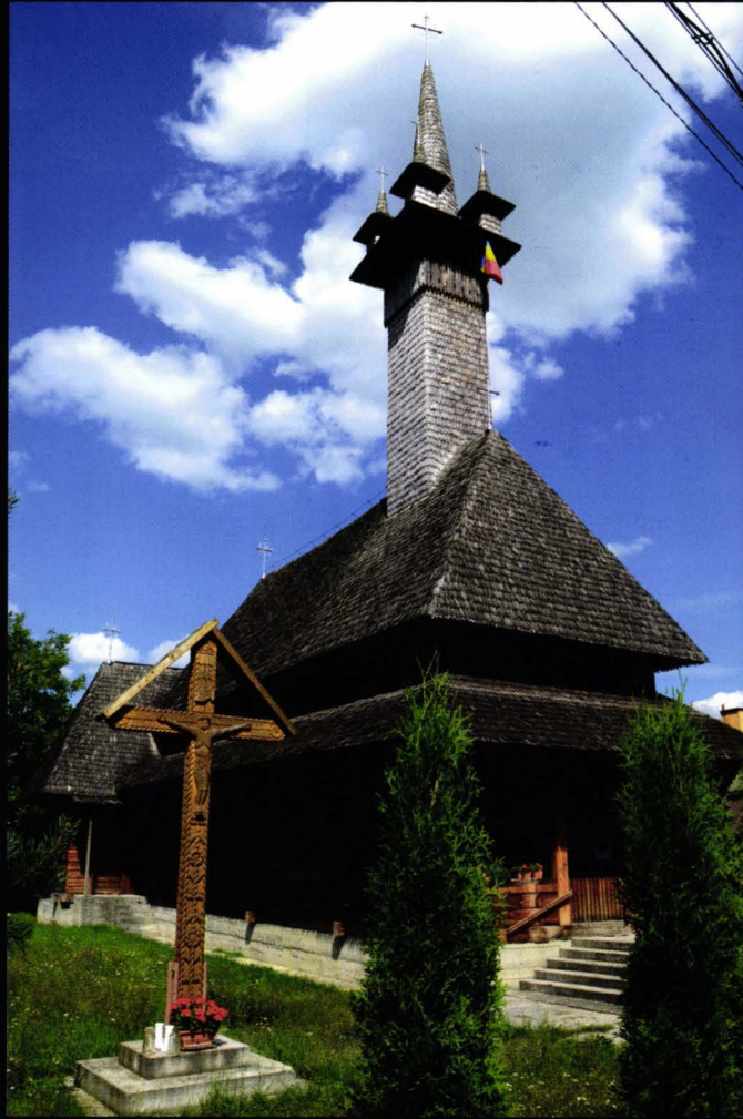
Biserica de lemn Greco - Catolică „Nașterea Maicii Domnului” A fost construită în perioada 1996-1997 A fost sfințită în anul 2000.
