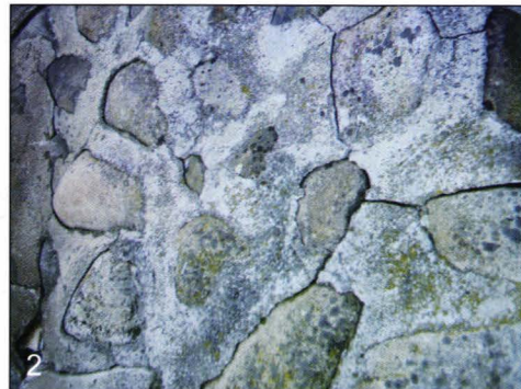
2. Tehnică de construcție Construction technique Építési technika
