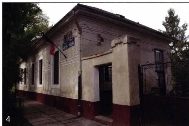
4. Primăria. Fosta casă notarială The town hall. Old notary A volt jegyzőház épülete, jelenleg Városháza
