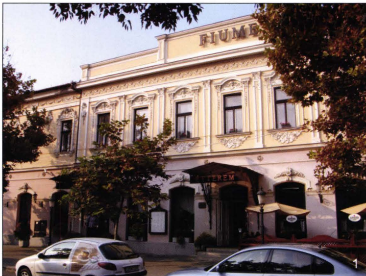
1-2. Hotelul Fiume Fiume hotels Fiume Szálló
