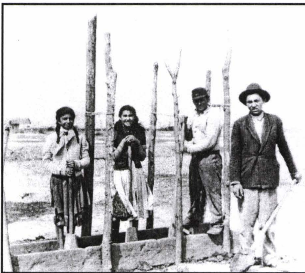
Țigani construind o casă în Chitighaz(1958)
