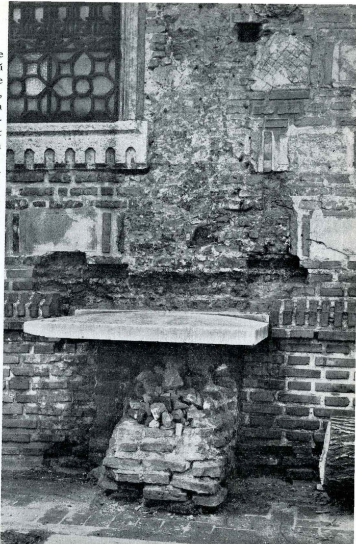
10. Urmele contrafortului de pe latura de nord a naosului
