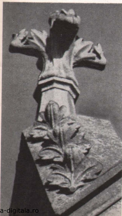
9. Fleron de contrafort al fațadei nordice
