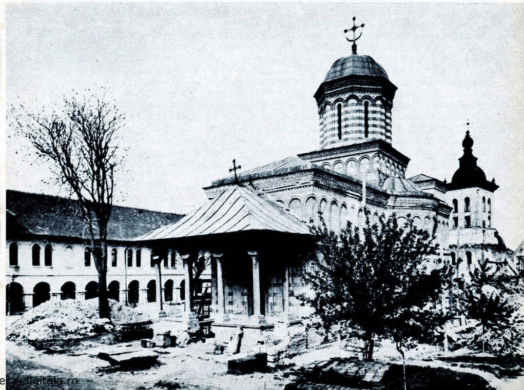
9. Biserica în timpul lucrărilor de restaurare
