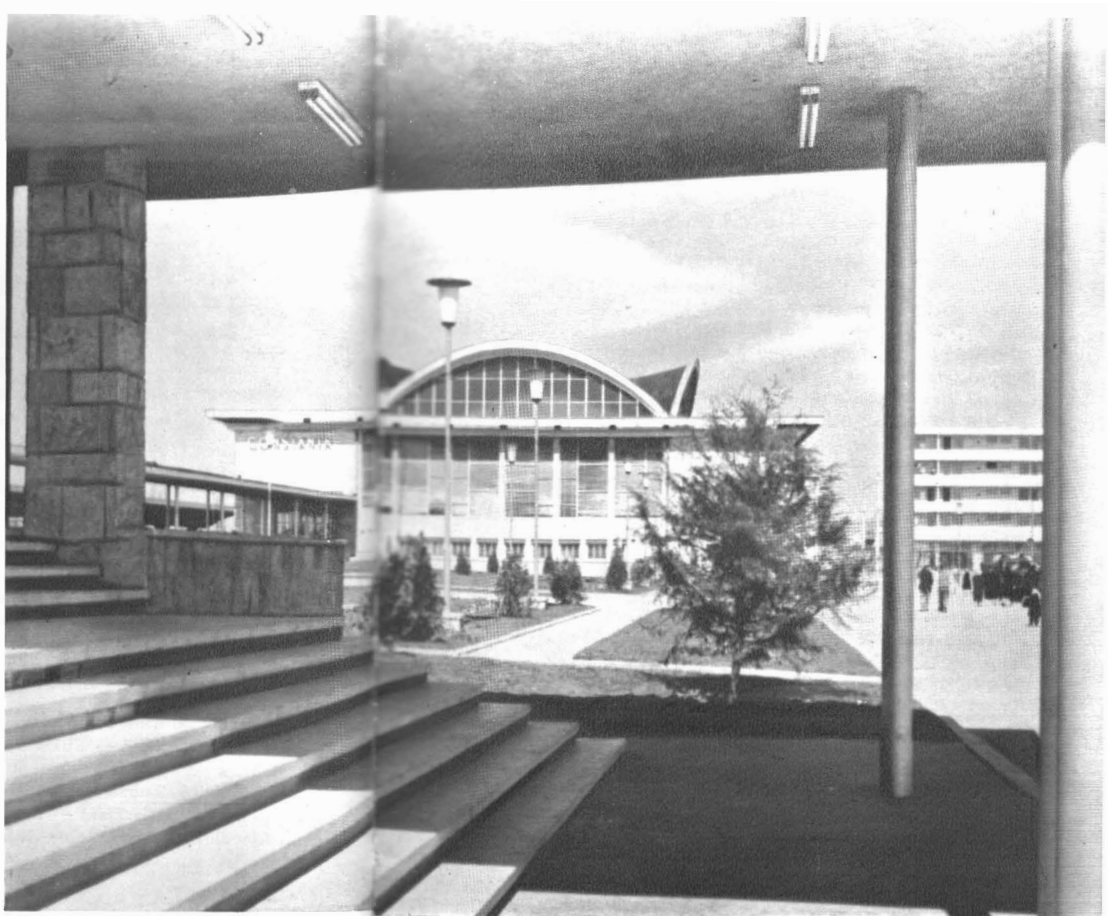
Le nouveau bâtiment de la gare de Constantza
