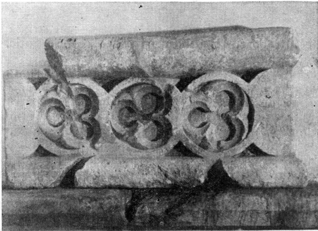
20. Reconstituirea unui fragment al balustradei gotice din piese asamblate.
