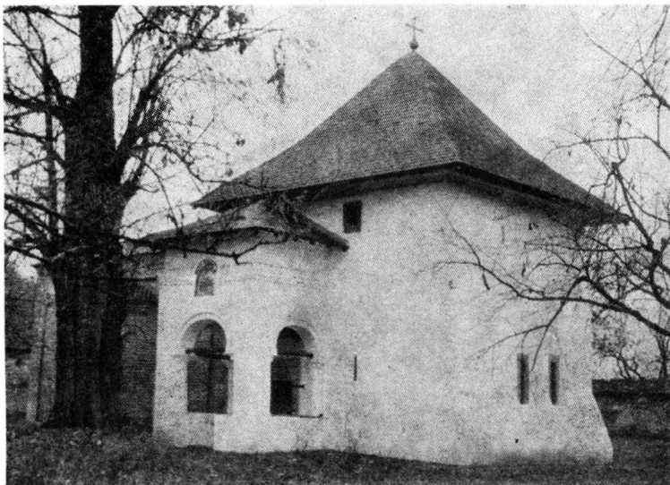
13. Biserica după restaurare. Vedere nord-vest.
