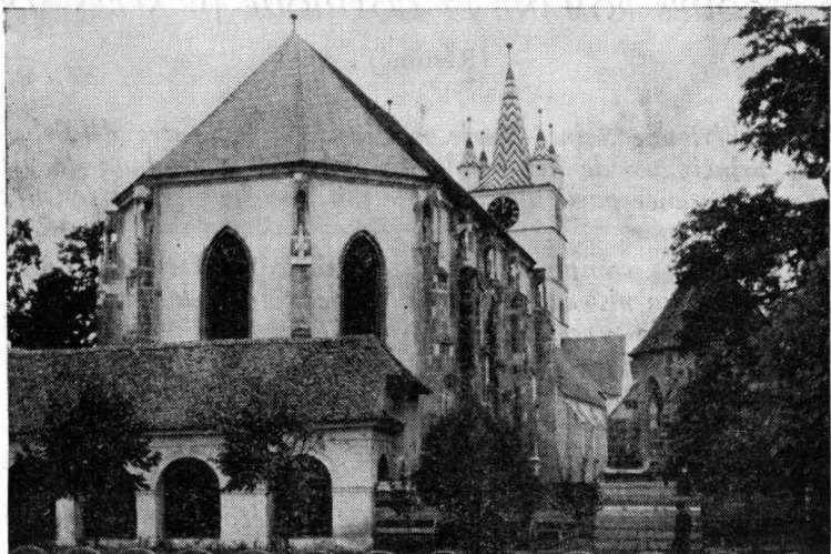
25. Vederea monumentului dinspre est, după degajare. 25. Vue du monument vers l'est, après son dégagement.
