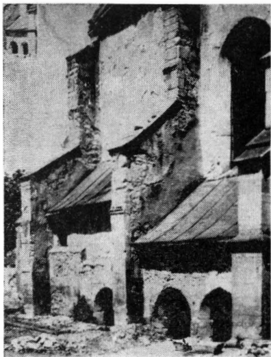
28 a. Galeria sud înainte de restaurare. 28. a. Galerie sud avant la restauration.
