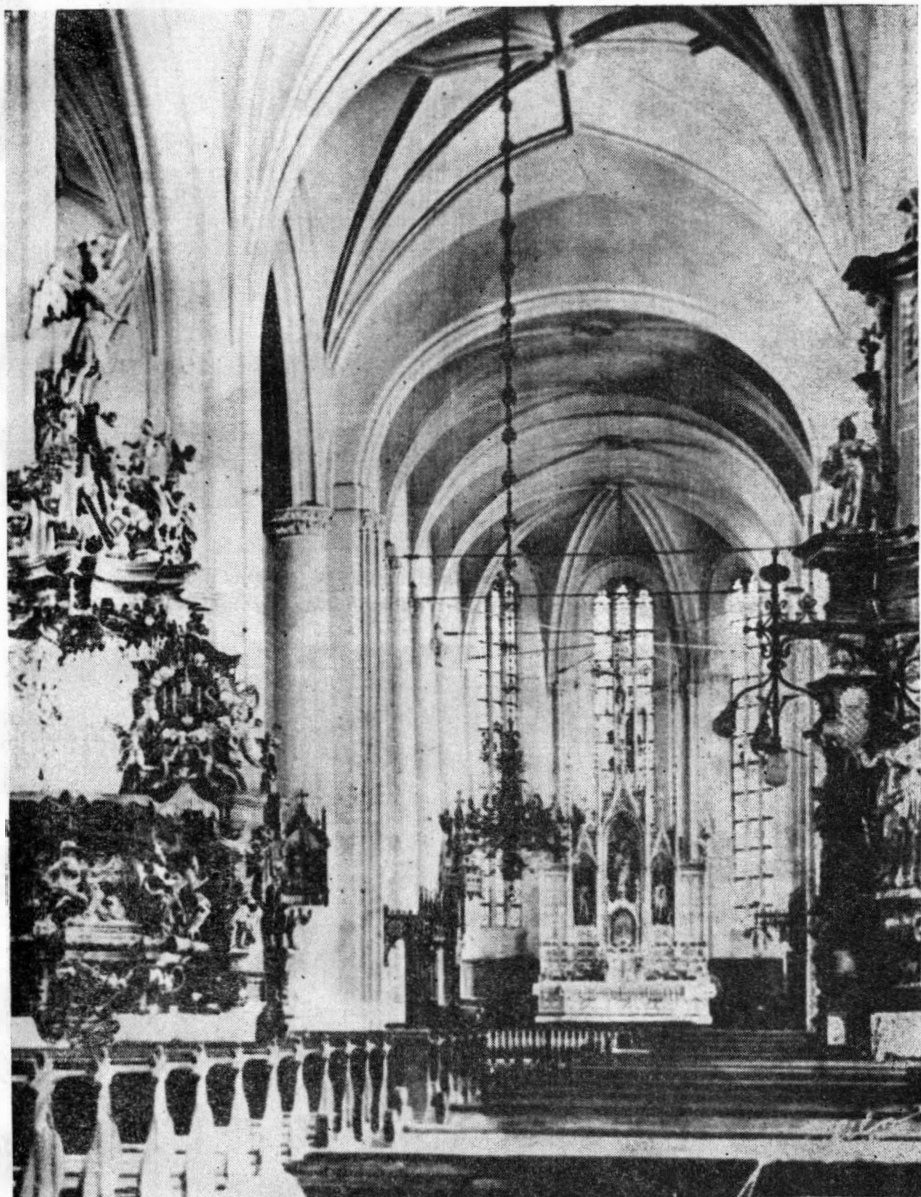
5. Interiorul corului înainte de restaurare.
