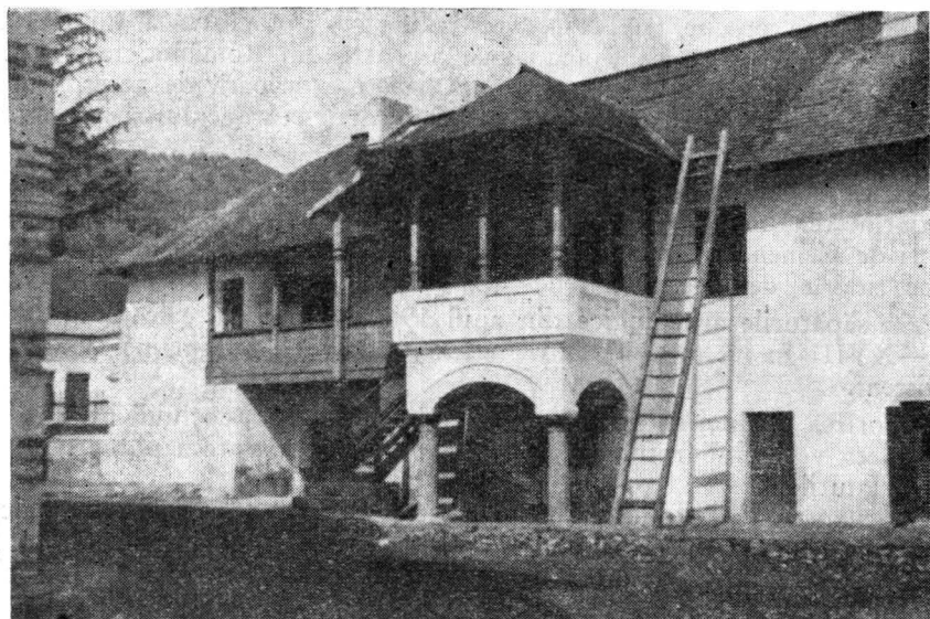
13. Pridvorul de pe latura nord după restaurare.
