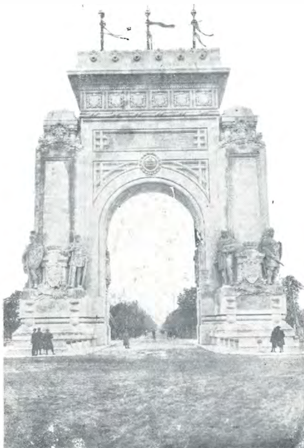
Arcul de Triumf dela Șosea. — Triumph Bogen im Parke „der Chaussée. — Arc de Triomphe à la chaussée.
