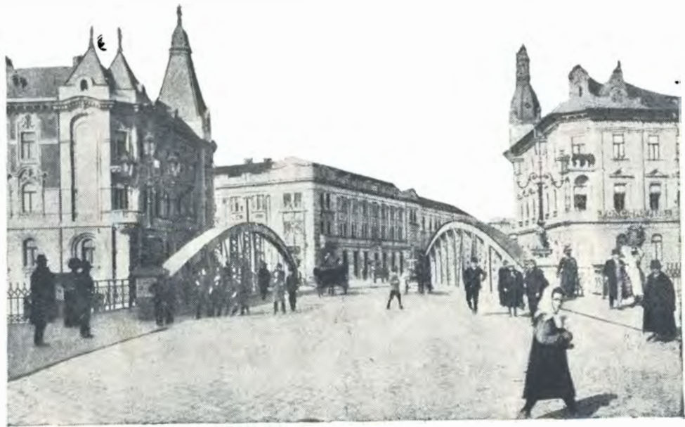
Podul de fer — Eisenbrücke — Pont de fer.
