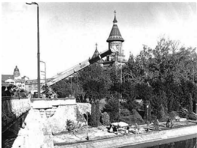
Detaliu din timpul instalării „Pernei”
