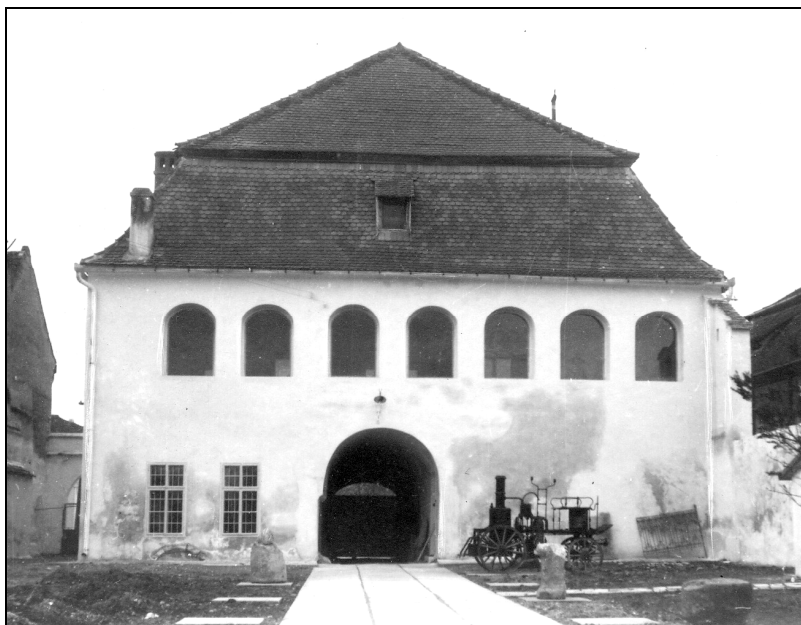
Fig. 22. Casa Zápolya - fațada de nord, cu loggia - după restaurarea din 1962-1964.
