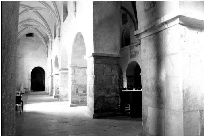
Fig. 4. Colaterala sudică a corpului bazilical – interior
