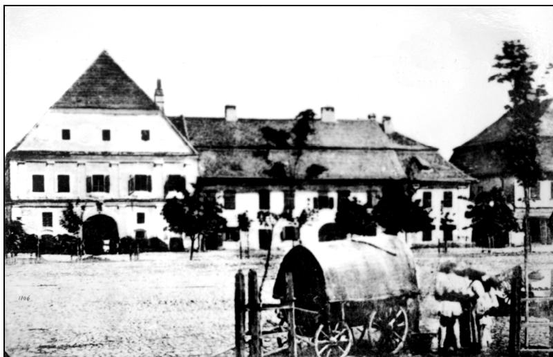
Fig. 23. Primăria veche - demolată în 1880
