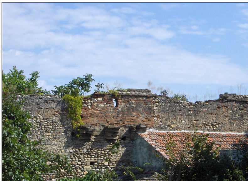
Fig. 17. Latura sudică a incintei - bovindou - fragment
