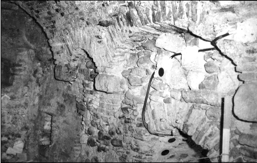
Fig. 18. Casa Zápolya - boltă semicilindrică cu penetrații, pe console - demisol.
