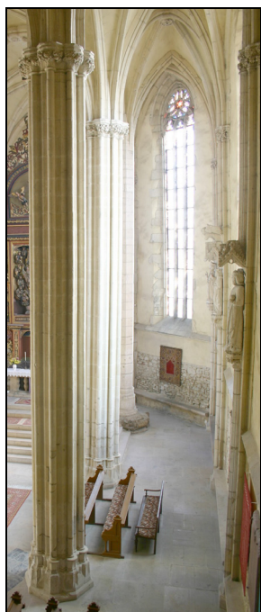
Fig. 7. Corul gotic – stâlpi.
