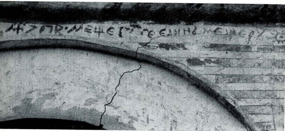
6. Iscălitura meșterilor lui Șerban Cantacuzino (fațada sud a pridvorului)
