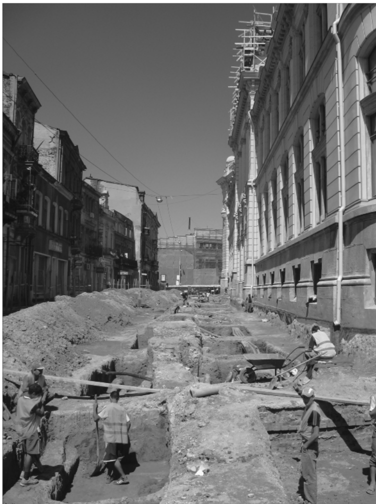
b. Str. Franceză, vedere generală dinspre biserica "Sf. Dumitru", traseu zid Z11
