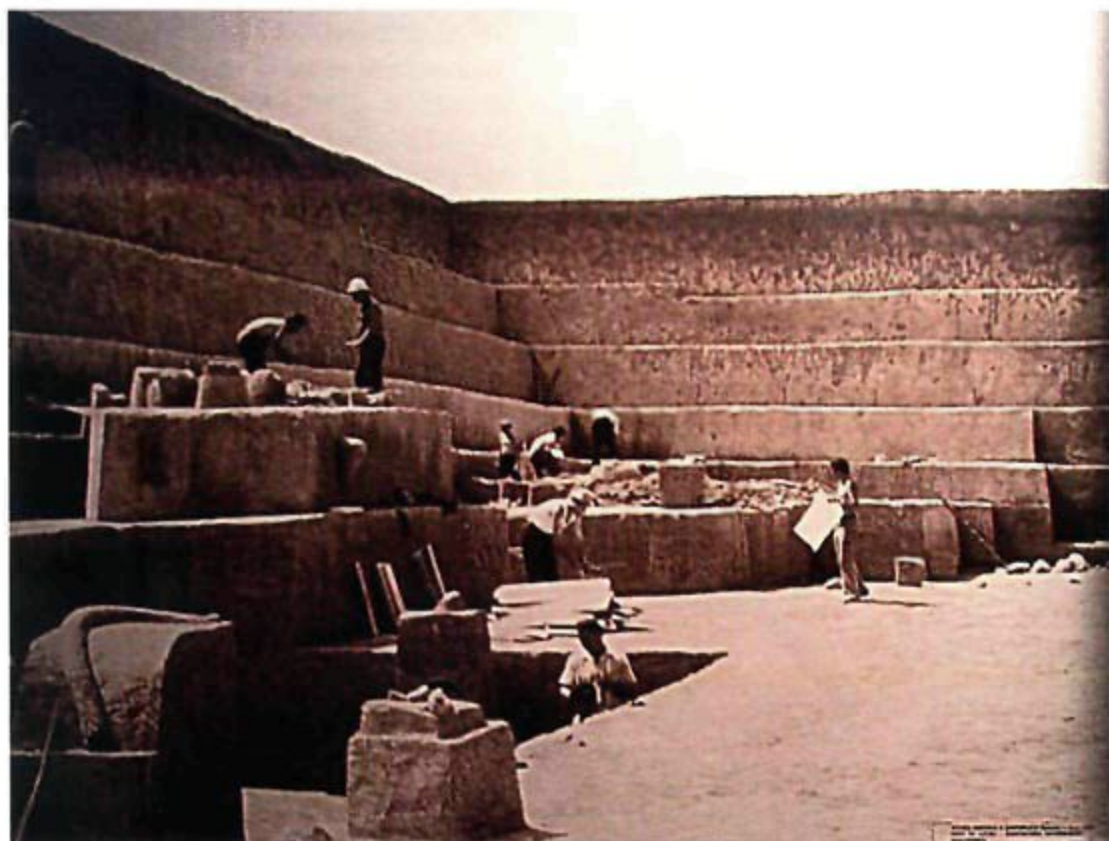
Fig. 5 Ripiceni-Izvor, vedere parțială a șantierului
