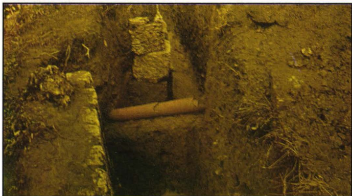
Fig. LI. Fețele Albe: conductă de apă in situ .
