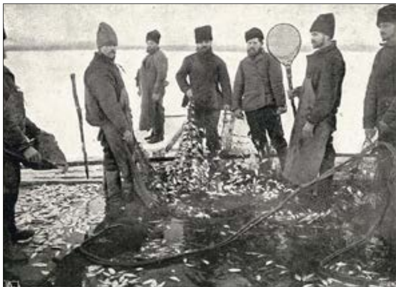
PESCUITUL CU NĂVODUL SUB GHEAȚĂ (II) Matia cu peștele prins și adunarea peștelui cu minciogul.
