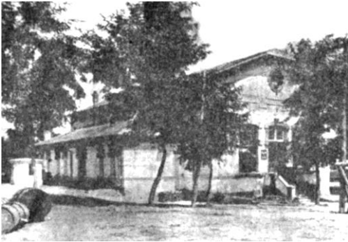
Uzina de apă și electricitate
