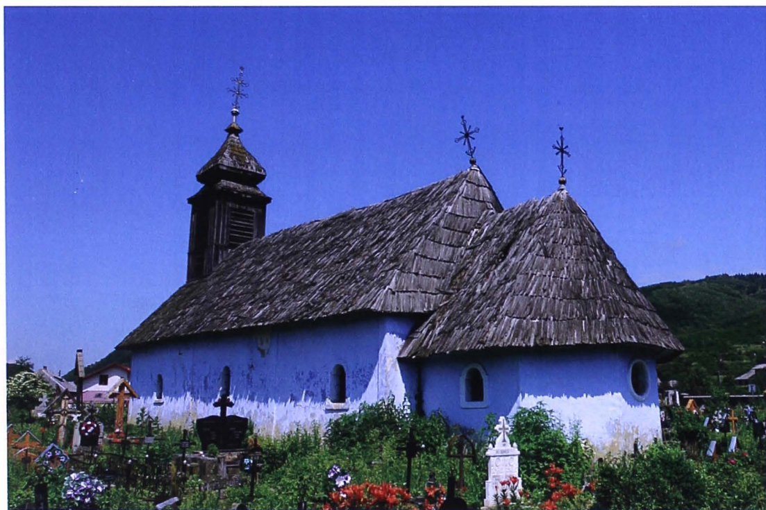
Fig. 3.7. Biserica în starea actuală vedere exterioară (foto: Timur, V.C., 2017)
