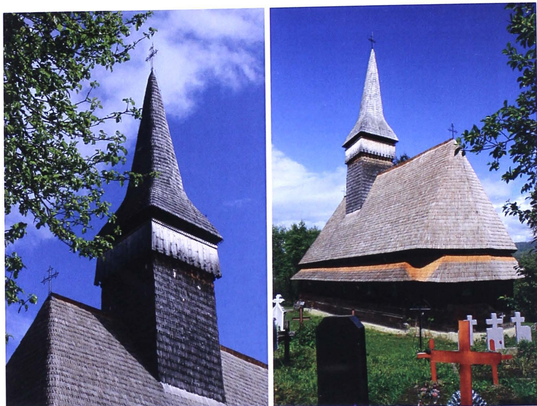
Fig. 3.46. Vedere panoramică a bisericii și turla. (foto: Timur, V.C., 2017)
