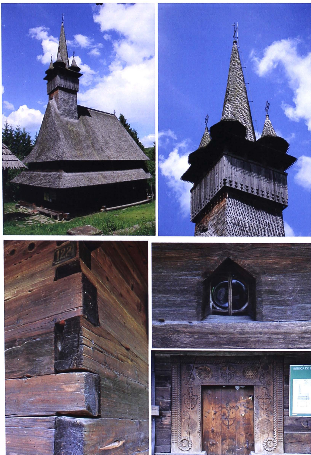
Fig. 3.25. Privire de ansamblu, îmbinarea, turla, fereastra și ancadramentul ușii. (foto: Timur, V.C., 2017)
