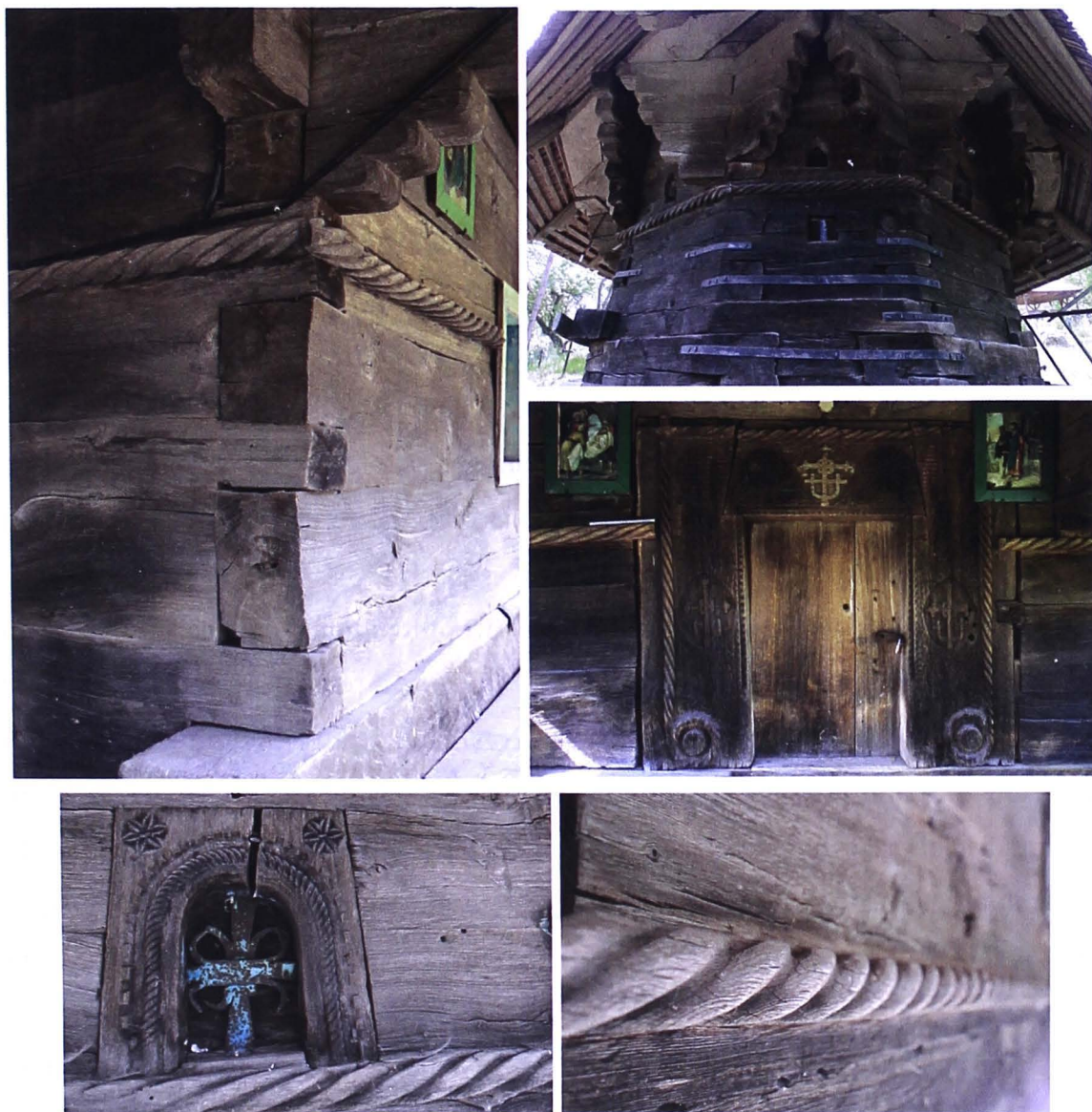
Fig. 3.34. Îmbinarea prin cheotoare netede cu dinte ascuns înăuntru; aspectul de navă al bisericii, cu altarul decroșat de formă poligonală, înconjurată de motivul decorativ "funia" - poziționată șub fereastra îngustă. Andcadramentul ușii sau portarul este de asemenea prezentat. (foto: Timur, V.C., 2017)
