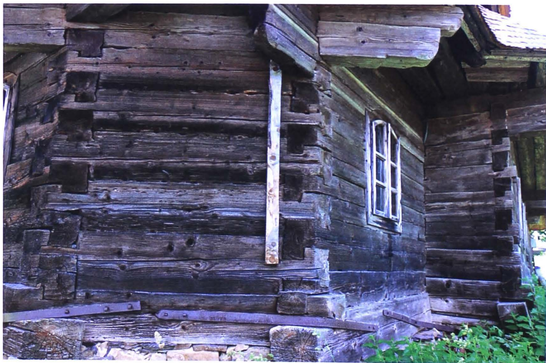
Fig. 3.31. Finisajele cu barda a bânelor de molid îmbinate în cheotoare în dinte. (foto: Timur, V.C., 2017)
