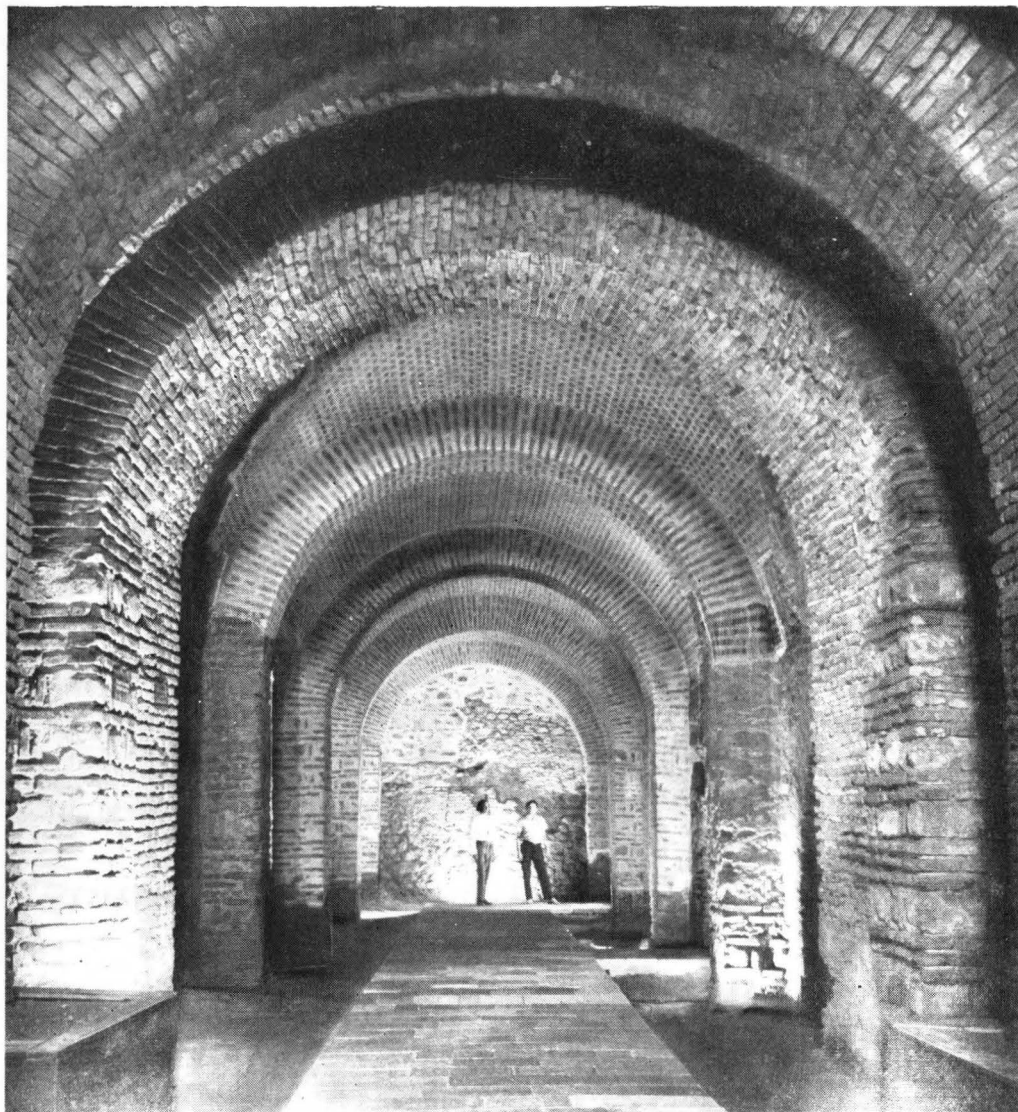
Fig. 14. Traveea de nord a subsolurilor Palatului Voievodal.
