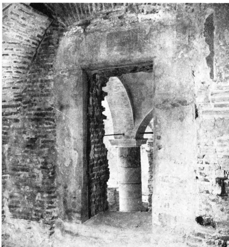
Fig. 30. Amprenta boltii originale pe peretele de est al sălii cu lunete.
