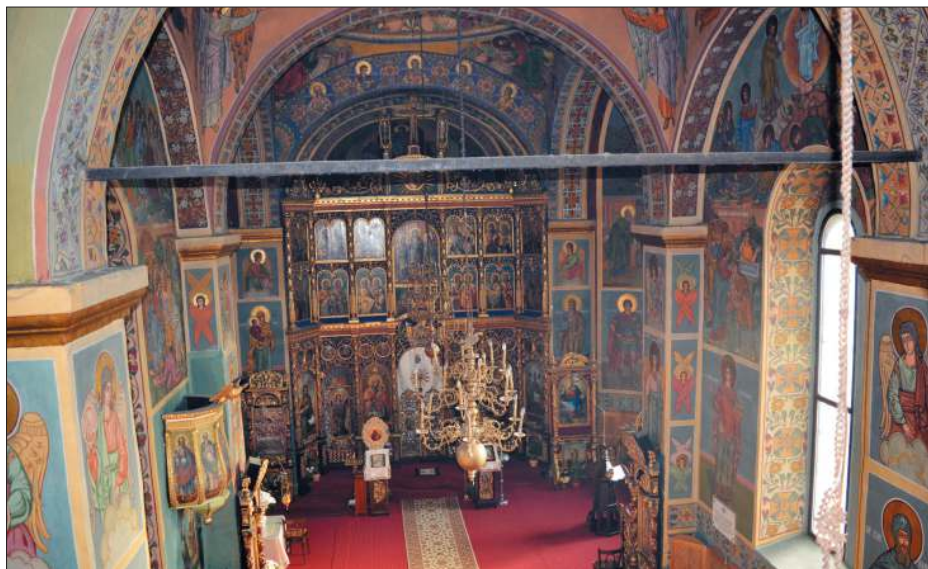
📍 Biserica „Adormirea Maicii Domnului” („Precista”). Zona naosului, cu tija de oțel care leagă zidurile exterioare ale pronaosului
