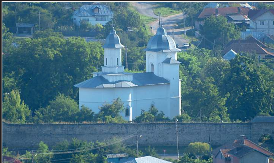
📍 Biserica „Buna Vestire” („Răducanu”). Vedere aeriană din nord. Se observă parte din zidul care înconjoară biserica (2008).
