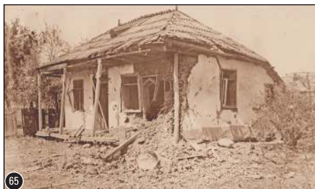
📍 Casă distrusă, asemenea altor câteva sute, în timpul bombardamentelor din august 1917
