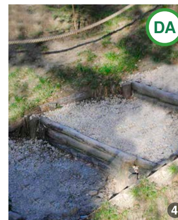
AȘA DA: Scări exterioare cu trepte din pietriș și contratrepte din lemn rotund despicat care se pretează pentru amenajări exterioare.
