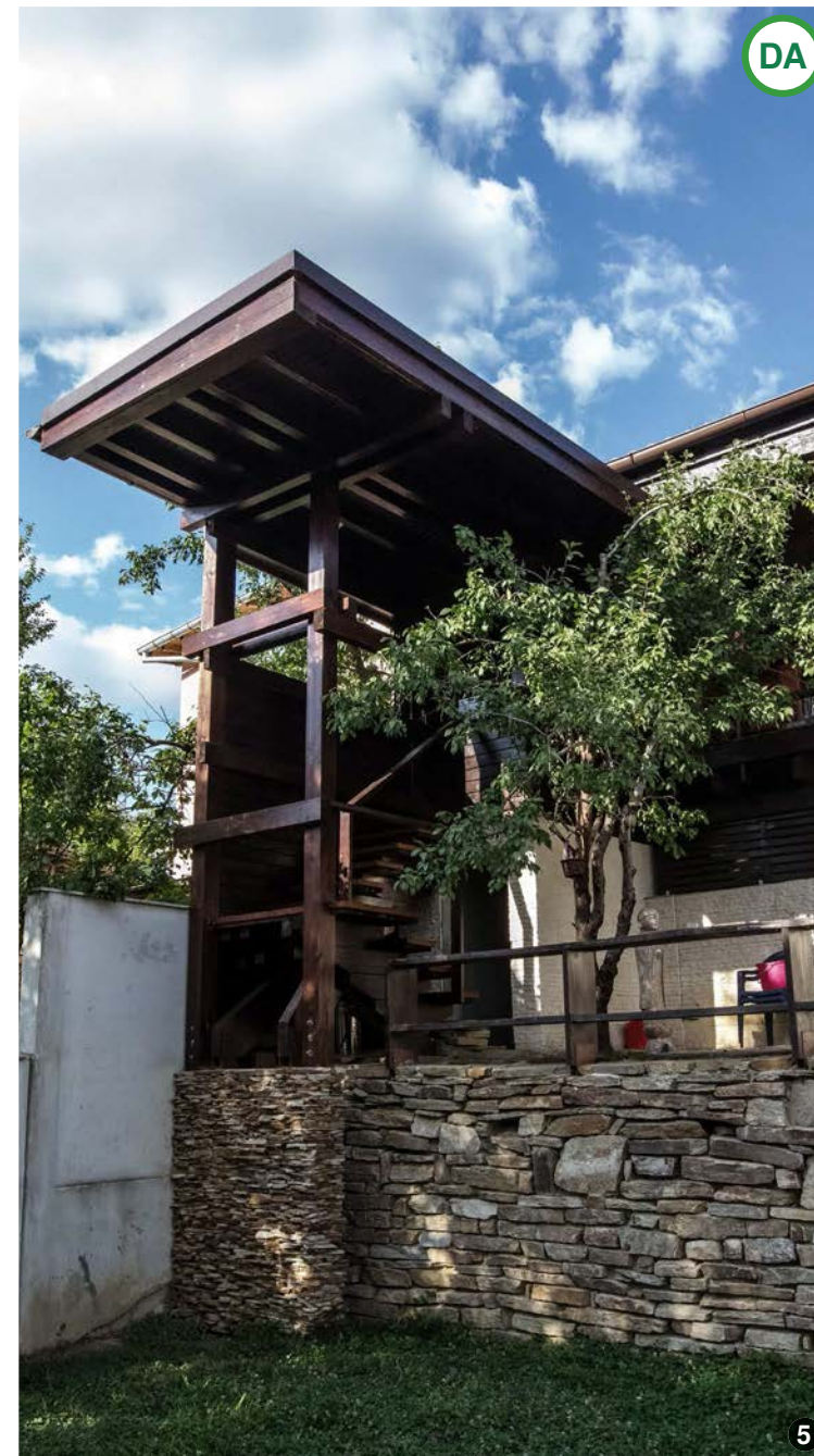
AȘA DA: Lemn și piatră folosite la o construcție nouă.
