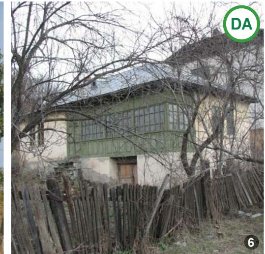
ASA DA: Exemple de închidere a prispei de dimensiuni mai mari, pe toată lungimea acestuia. Proporția și dimensiunile ochiurilor de geam păstrează armonia generală a clădirii.
