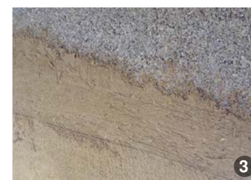
AȘA DA: Pereți cu termoizolație din Hempcrete.
