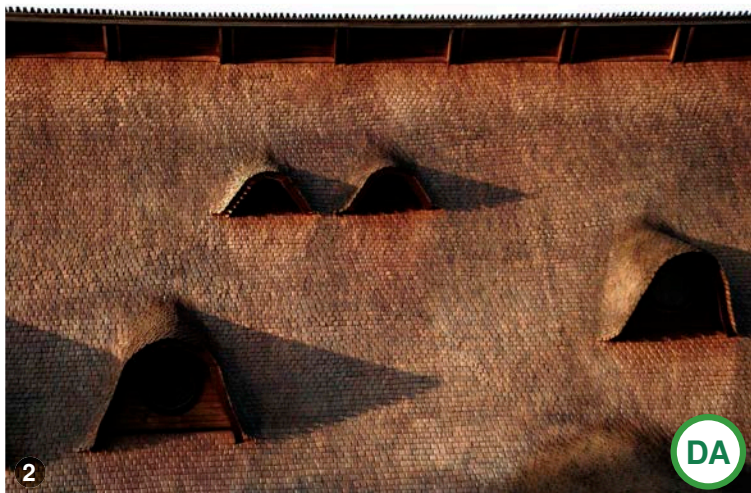
AȘA DA: Învelitoarea din șindrilă poate fi folosită și la construcțiile noi cu gabarite mari care se încadrează armonios în peisaj, utilizând astfel materialele de construcție locale și mână de lucru locală.
