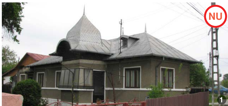
AȘA NU: Foișorul are o închidere cu sticlă necorespunzătoare, cu goluri mari și tâmplărie metalică.
