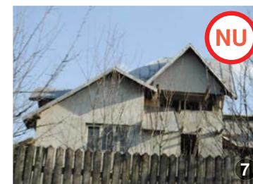
AȘA NU: Soluția acoperișului „jucat” al clădirii noi contrastează puternic cu sobrietatea clădirilor tradiționale.
