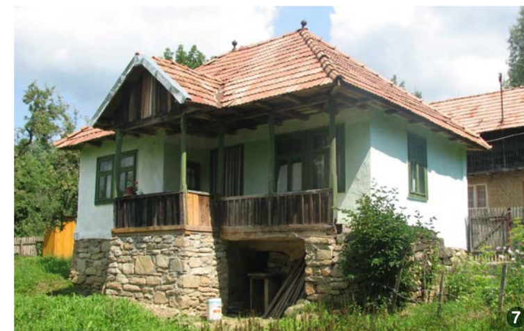
Casă cu pereți din lemn cu umplutură din pământ, așezați pe un beci construit din bolovani.
