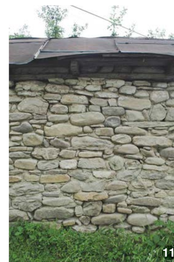
Împrejmuire din zidărie de piatră.
