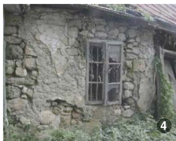
Zidărie din piatră.
