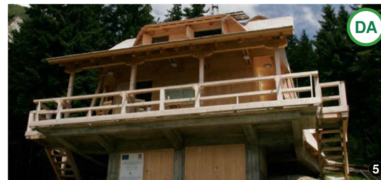
AȘA DA: Clădire realizată într-o zonă înaltă având rol de cabană, realizată cu tehnici tradiționale și cu materiale locale.
