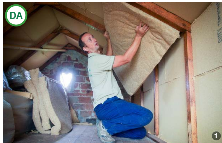
AȘA DA: Termoizolația din cânepă: montare rapidă și simplă. Nu este necesar un costum de protecție, deoarece produsul nu irită pielea și nu conține substanțe periculoase pentru mediu sau sănătate.
