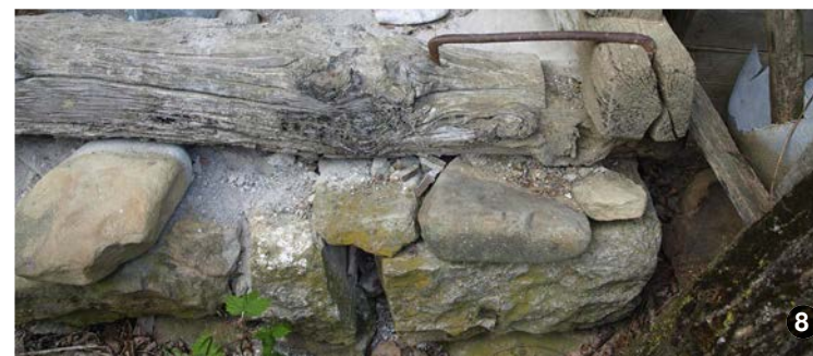
Fundație și soclu de piatră.
