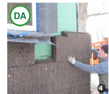
ASA DA: Plăci izolatoare din plută expandată
