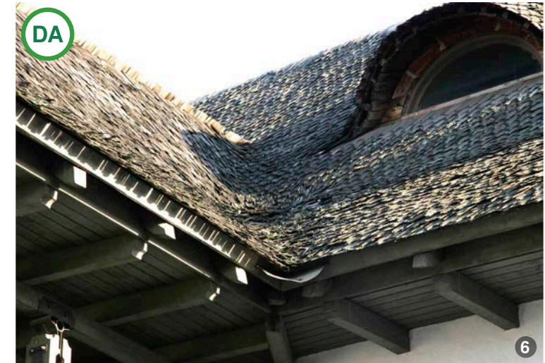
AȘA DA: Clădire nouă cu gabarit mare care poate constitui un mod de a acoperi construcții cu gabarit mare folosind acoperiș cu patru ape și învelitoarea din șindrilă.
