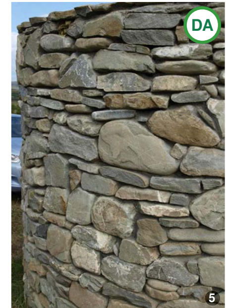
AȘA DA: În zonele cu acces facil la carierele de piatră sau la albiile râurilor, s-a folosit preponderent piatră pentru zidurile clădirilor și a zidurilor de sprijin.
