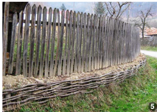
Zid de sprijin din împletitură de nuiete și împrejmuire din lemn.
