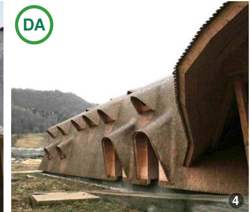
AȘA DA: Clădire nouă cu gabarit mare care poate constitui un mod de a acoperi construcții cu gabarit mare folosind acoperiș cu patru ape și învelitoarea din șindrilă.
