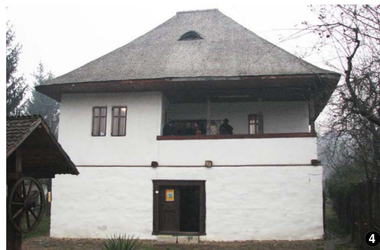
AȘA DA: Prispa se poate desfășura pe o latură întreagă (menționăm că latura trebuie să fie cea lungă) sau prispa poate fi parțială (pe două treimi din latură).
