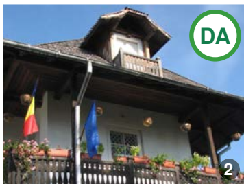
AȘA DA: Lucarna de formă rectangulară este o soluție de iluminare a mansardei atât la clădirile acoperite cu șindrilă, tablă cât și țiglă.
