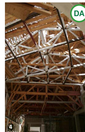
AȘA DA: Pentru construcții cu deschideri mari se pot folosi sisteme combinate de metal cu lemn.
