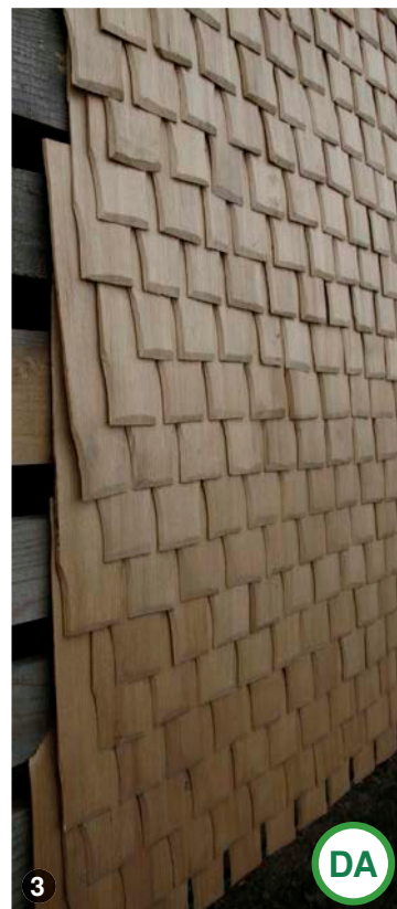
AȘA DA: Șindrița tradițională este o soluție recomandată, atât pentru înlocuirea învelitorilor istorice degradate, cât și pentru construcțiile noi.
