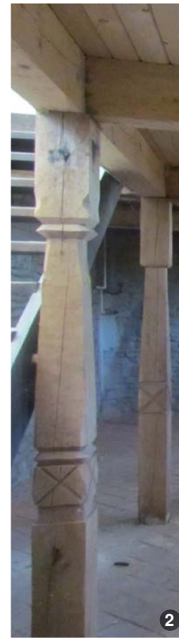
Stâlpi din lemn sculptați care nu respectă specificul local al decorațiilor stâlpilor din județul Prahova
