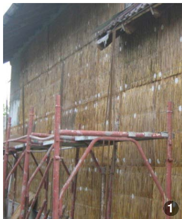
ASA DA: Exemple de pereți plăcați cu panouri termoizolante de stuf.
