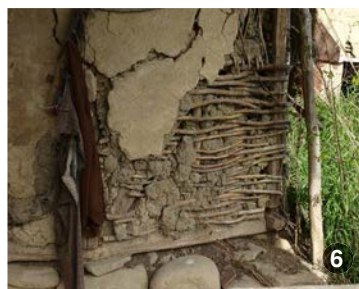
Detaliu de parament al unei case din lemn: tencuială din lut cu armătură din nuiele.
