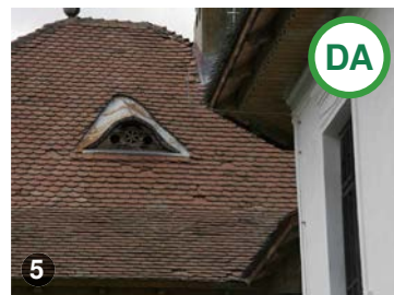
AȘA DA: Lucarnă într-un acoperiș cu învelitoare din țiglă cu mențiunea că lucarna trebuie să fie acoperită cu același tip de învelitoare.
