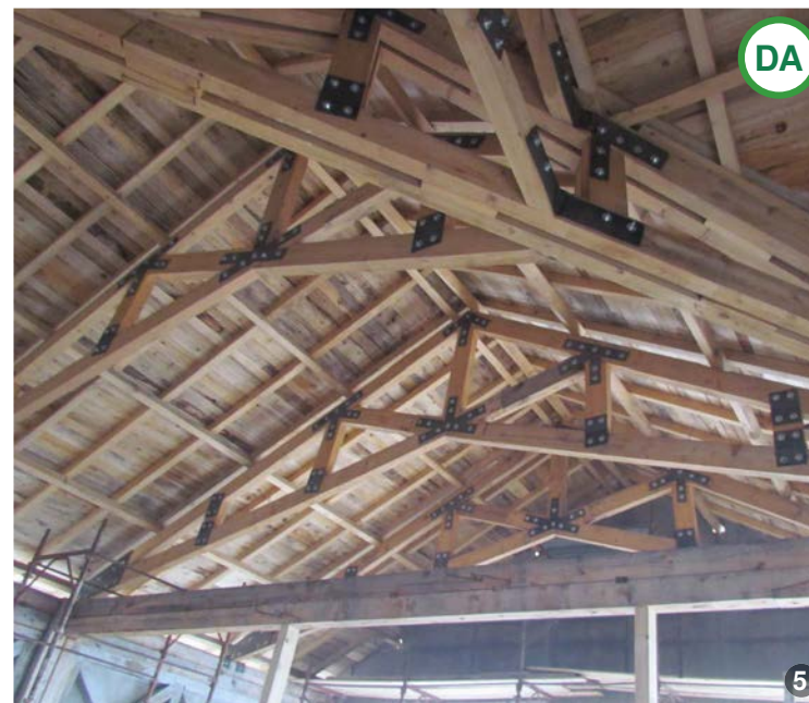
AȘA DA: Realizarea structurii din lemn pentru diferite deschideri.
