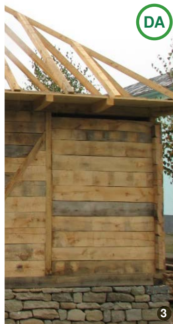
AȘA DA: Construcție nouă cu structură din lemn și fundație din piatră.
