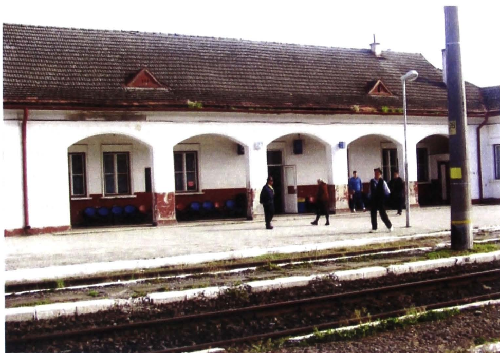
Fig. 38. Clădirea principală a stației de cale ferată
