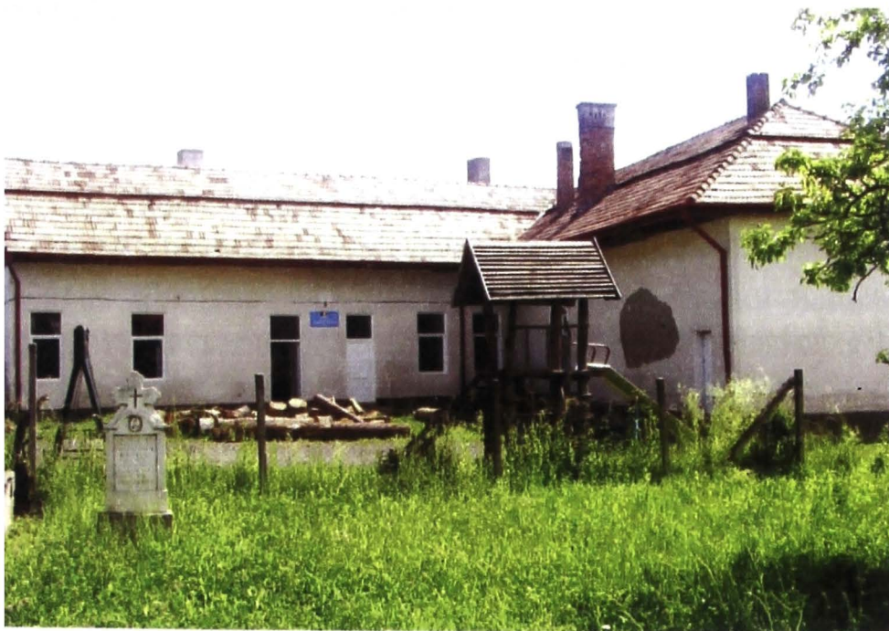
Fig.37. Școala din anul 1907. Fațada dinspre curte
