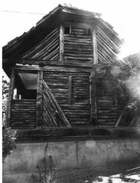
Casă de lemn cu stâlpi verticali între care se introduceau bârne
