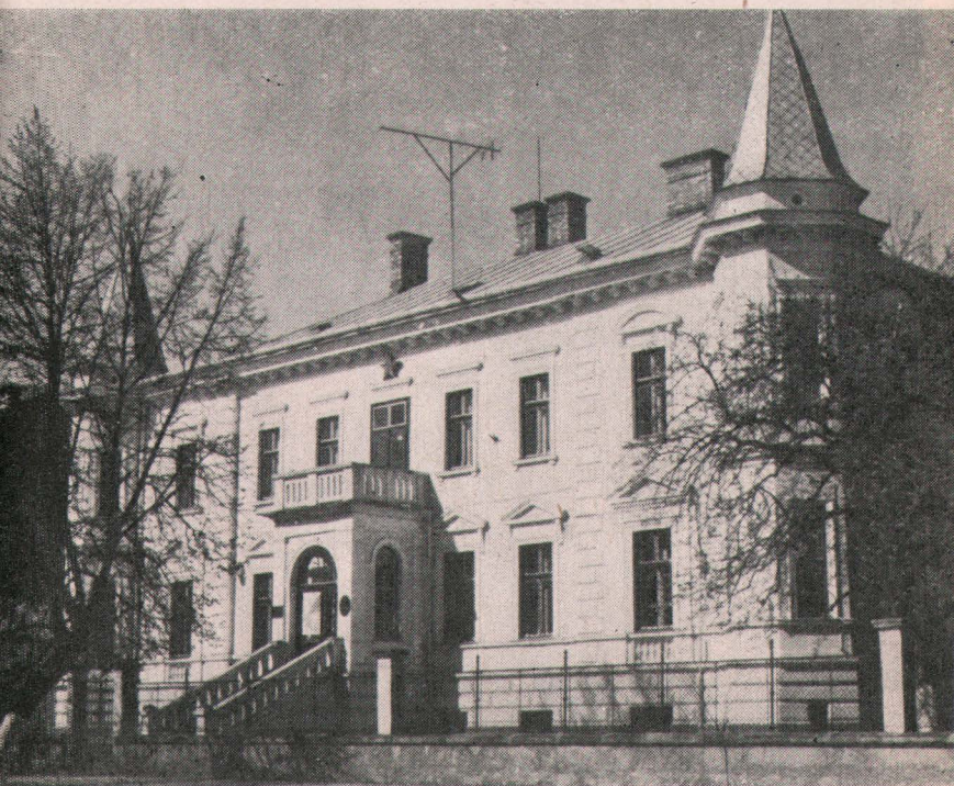
Banca Națională a R.S.R., Filiala Bistrița; construcție de la începutul sec. al XX-lea.
