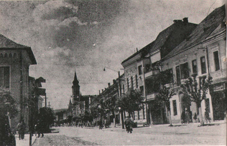
Vedere generală din str. Teilor, cu clădiri de la sfârșitul sec. al XIX-lea.
