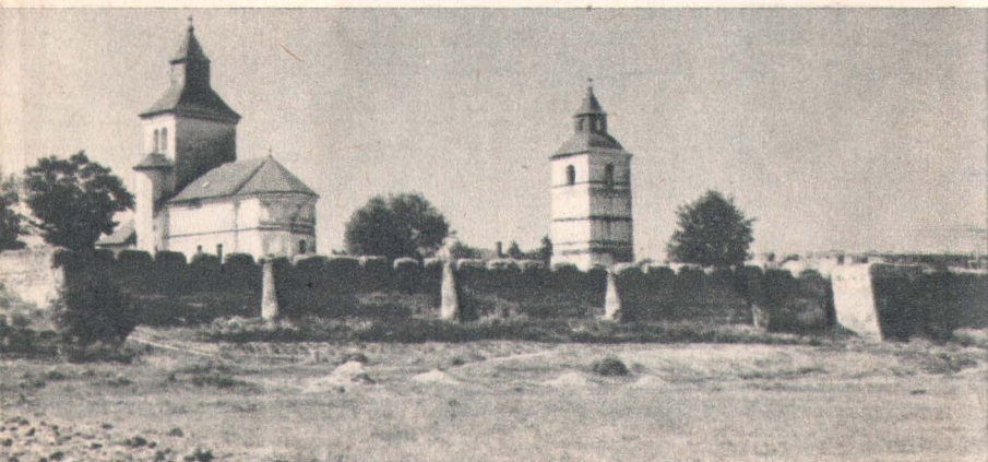
19. Mănăstirea Strehaia văzută dinspre est
