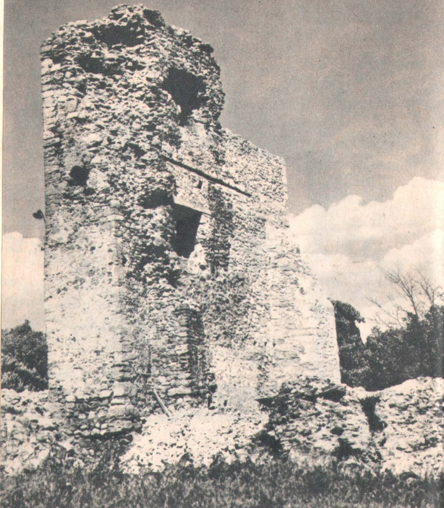
2. Cetatea Severinului: zidul turnului din colțul de nord-est
