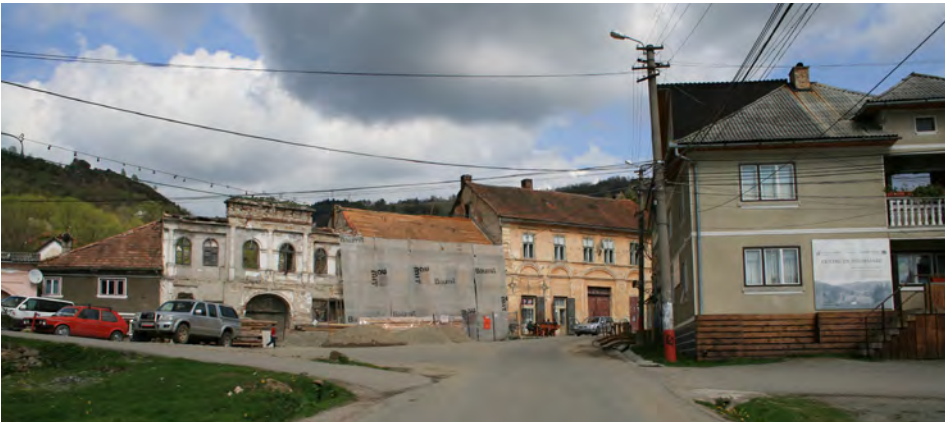
Fig. 7. Roșia Montană, mai 2008: vedere spre Casa 325 din Piața Veche în timpul lucrărilor de restaurare (fotografie: Radu-Alexandru Dragoman)
