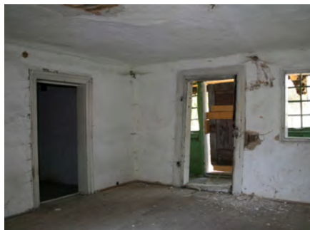
Fig. 25. Roșia Montană, septembrie 2011: Casa 519; prima cameră
