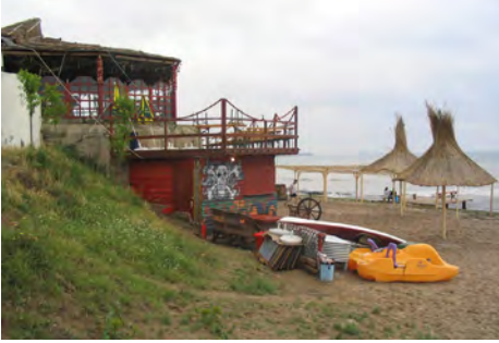
Fig. 10. Cazemată de la Vama Veche transformată în bar de plajă – Expirat (iulie 2005).
