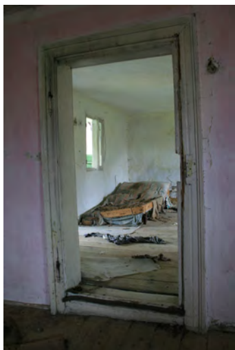
Fig. 13. Roșia Montană, mai 2008: Casa 519; vedere spre prima cameră (fotografie: Radu-Alexandru Dragoman)
