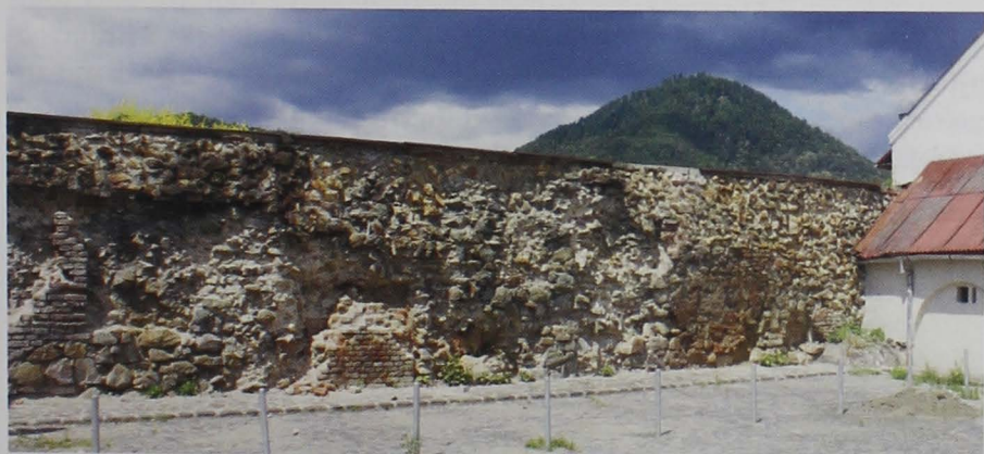
Fragment din zidul de apărare al orașului, situat pe str. Monetăriei
